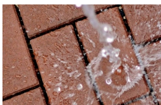
Pavimentação concreto permeável vermelho
