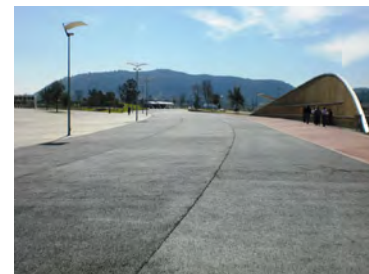
Estacionamento com pavimentação de ECOCRETO Ecológico Permeável
