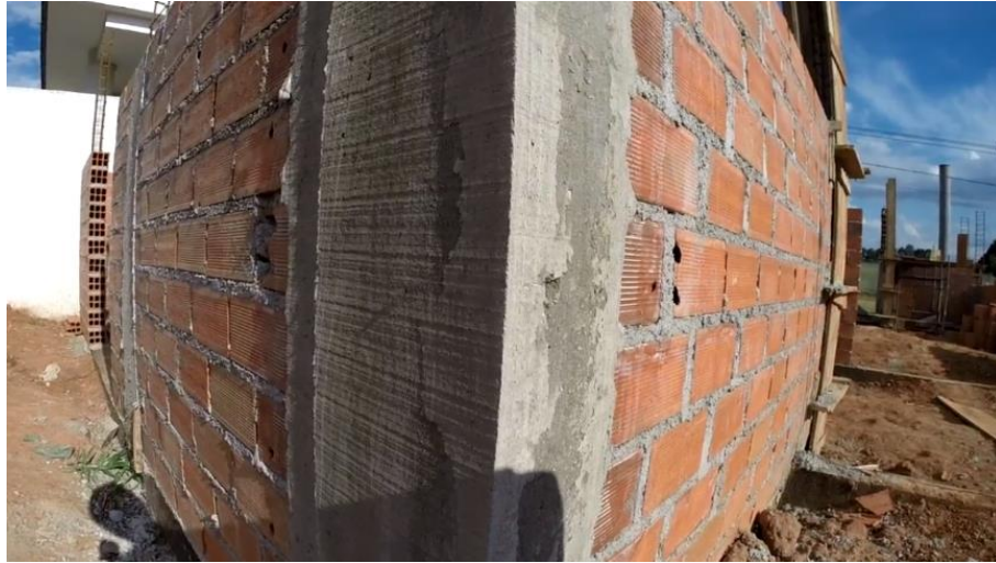
Figura 31 – Desforma dos pilares
