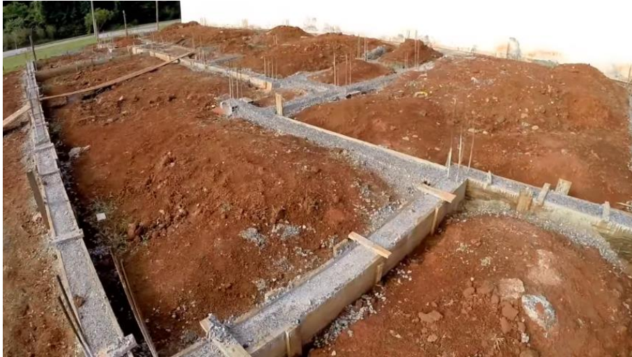
Figura 21 – Concretagem das vigas baldrame
