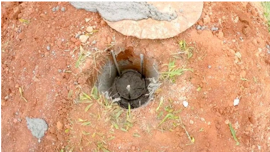
Figura 16 – Estacas concretadas
