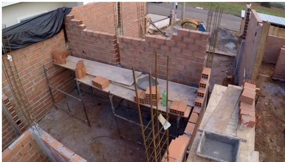
Figura 30 – Assentamento da segunda etapa da alvenaria
