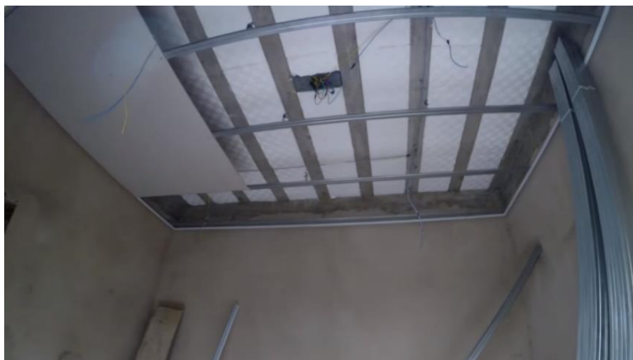
Figura 61 – Instalação do forro de gesso acartonado
