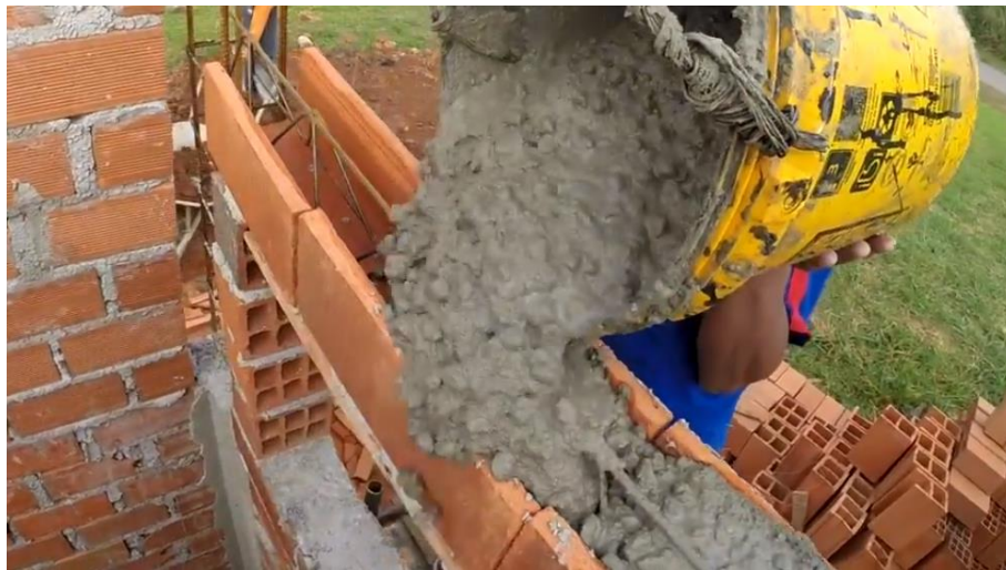
Figura 32 – Concretagem das vergas e contra vergas
