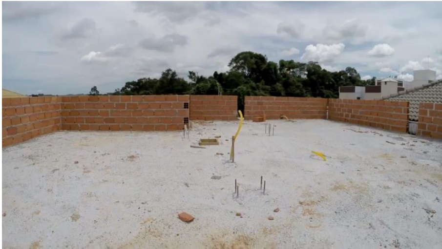
Figura 42 – Alvenaria da platibanda
