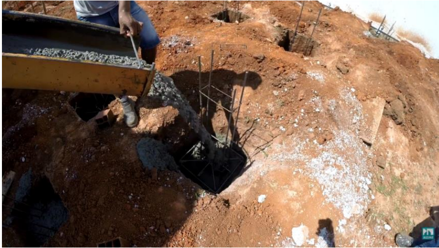
Figura 19 – Concretagem dos blocos de fundação
