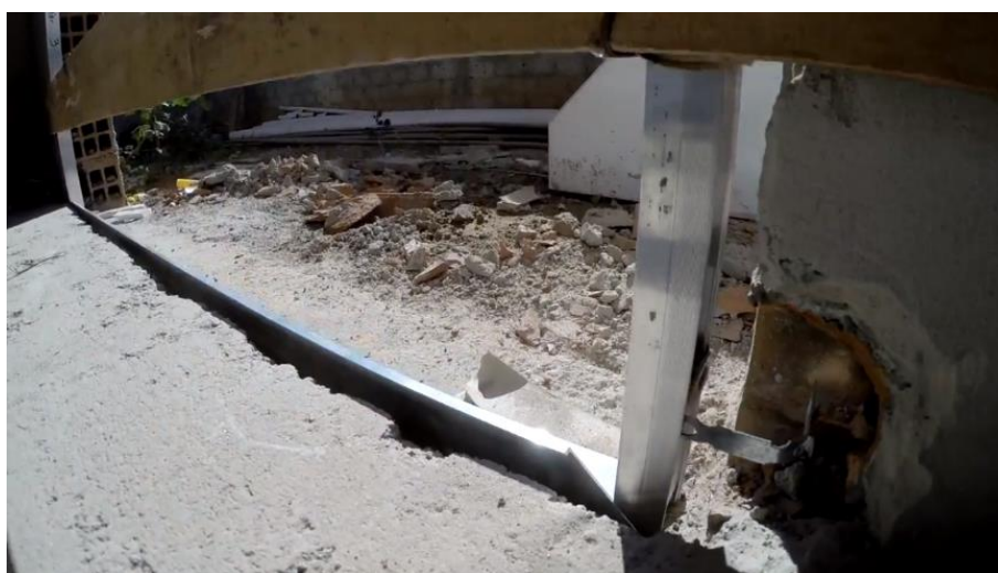
Figura 64 – Instalação dos contramarcos, soleiras e pingadeiras
