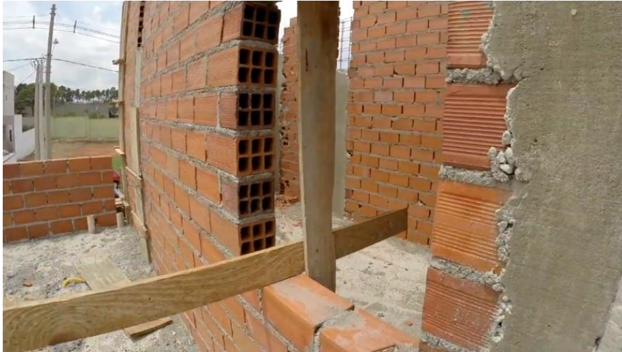
Figura 43 – Alvenaria da caixa d'água
