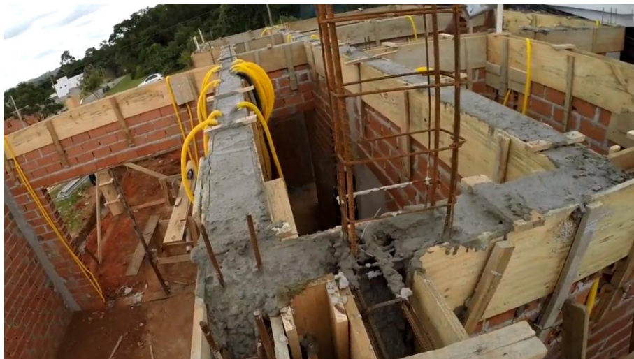
Figura 36 – Concretagem das vigas superiores
