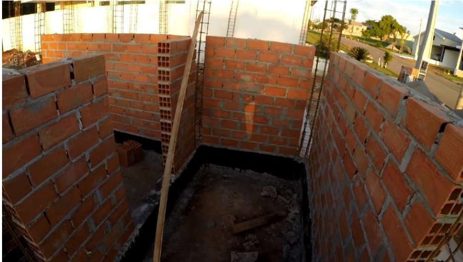
Figura 25 – Assentamento da primeira etapa da alvenaria
