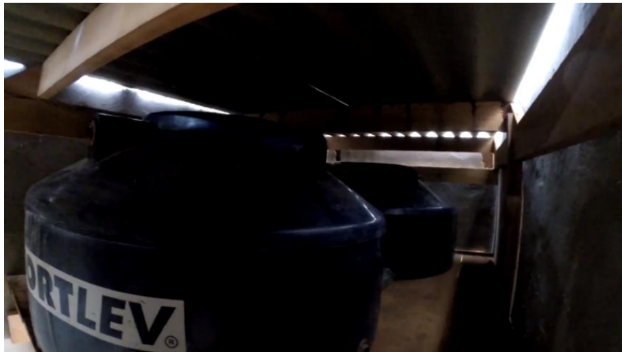
Figura 57 – Instalação das caixas d'água
