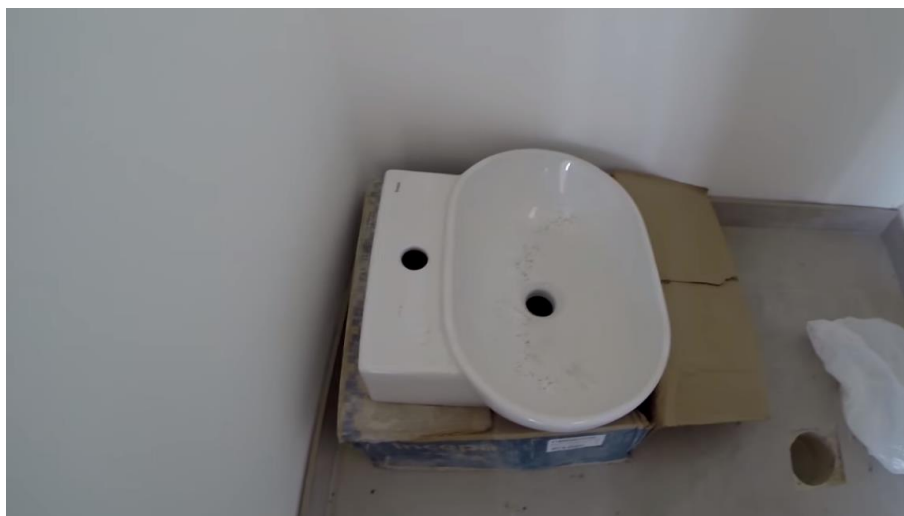
Figura 76 – Instalação das pias
