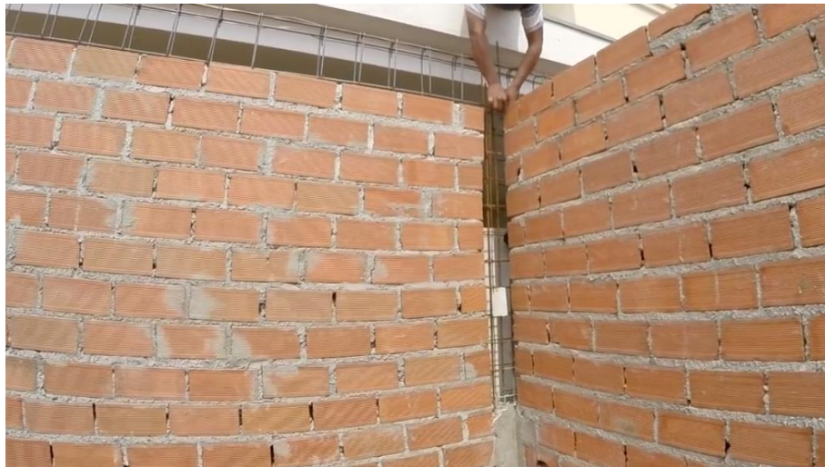
Figura 33 – Amarração das ferragens das vigas superiores
