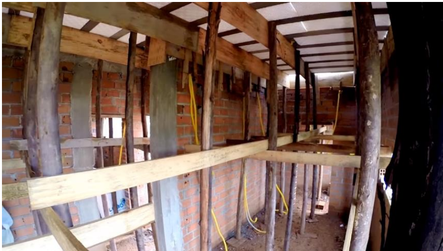
Figura 38 – Escoramento da laje
