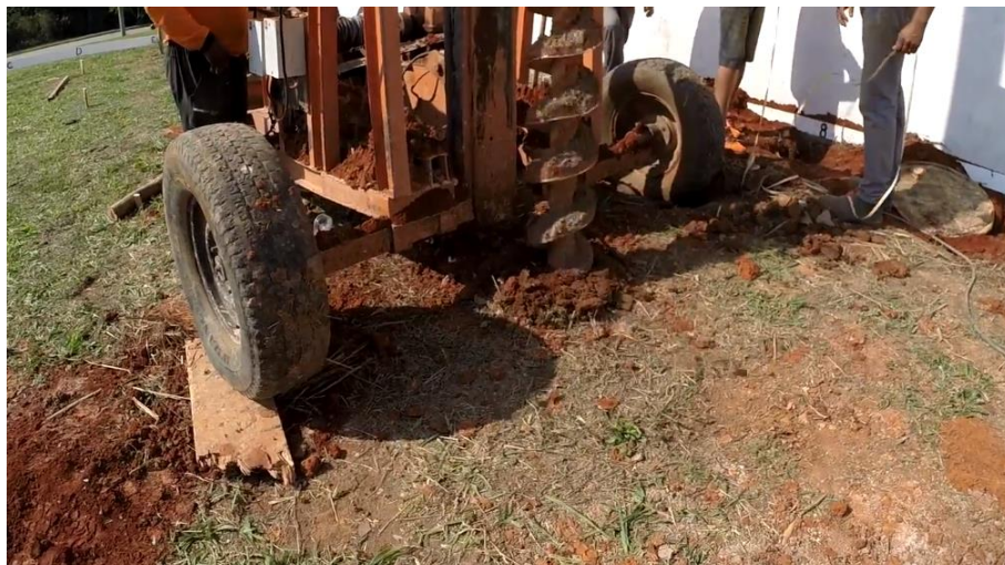
Figura 14 – Perfuração das estacas
