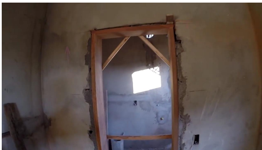
Figura 66 – Instalação dos batentes das portas
