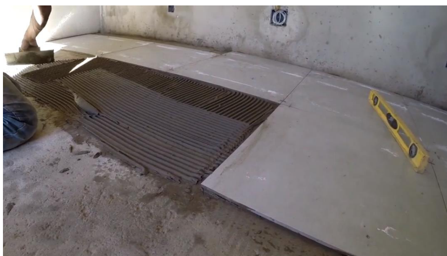
Figura 68 – Assentamento do piso
