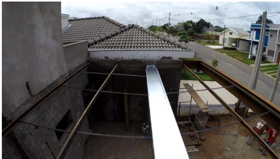
Figura 58 – Estrutura da cobertura da garagem
