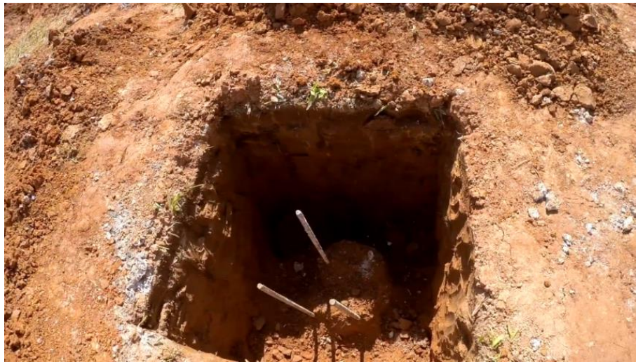
Figura 17 – Escavação manual dos blocos de fundação
