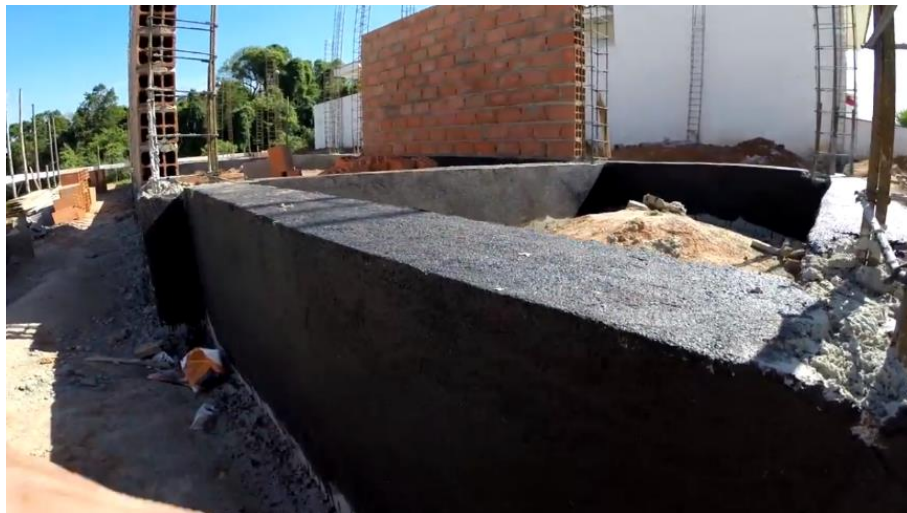
Figura 24 – Impermeabilização das vigas baldrames e início da alvenaria
