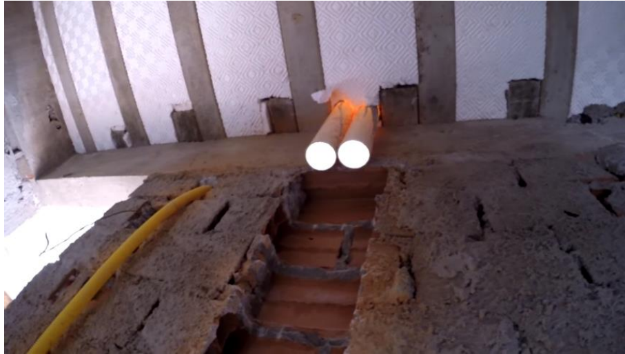
Figura 45 – Passagem dos tubos de quedas
