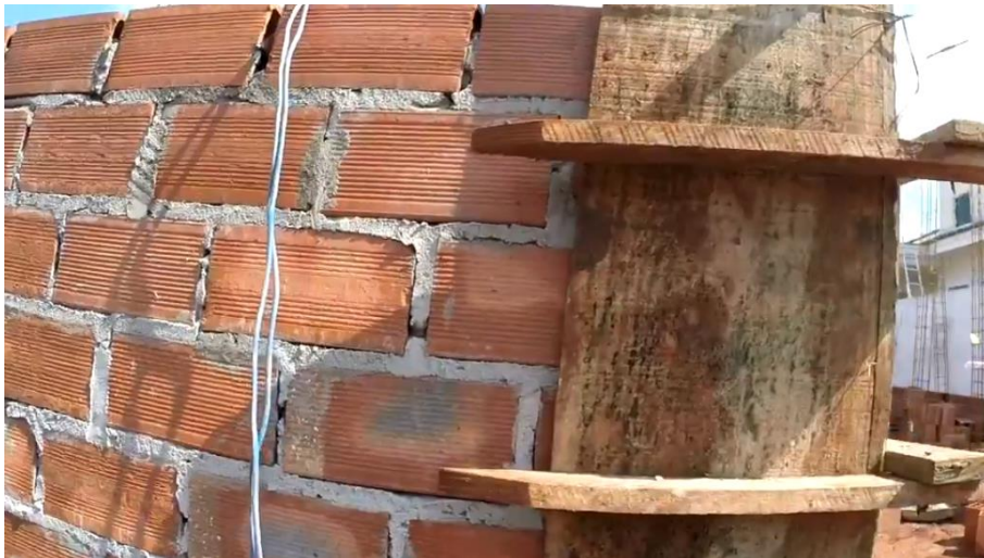
Figura 28 – Execução das formas dos pilares
