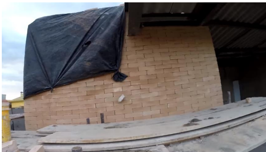
Figura 73 – Execução da fachada
