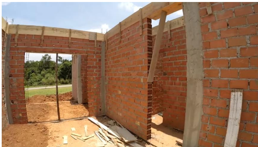
Figura 34 – Formas das vigas superiores e pilares concretados
