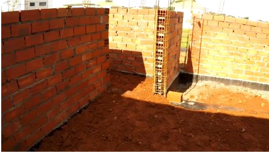
Figura 27 – Conclusão da primeira etapa da alvenaria e início do aterro
