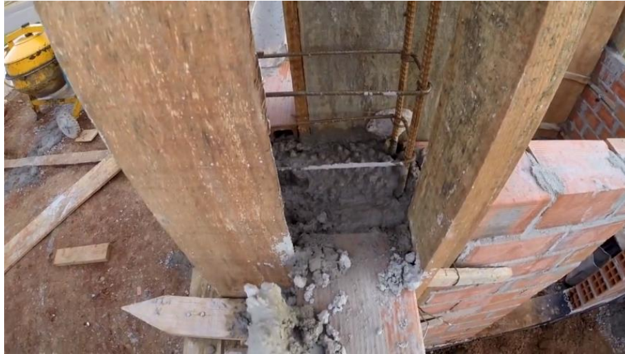
Figura 29 – Concretagem dos pilares
