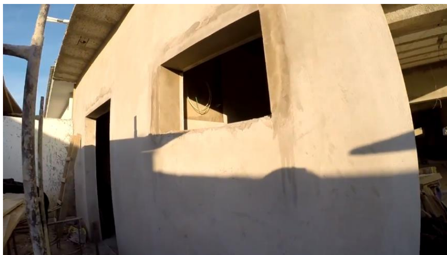
Figura 63 – Reboco da parte externa
