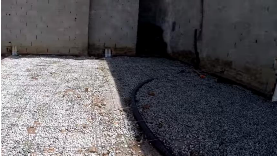
Figura 47 – Disposição da brita e das malhas
