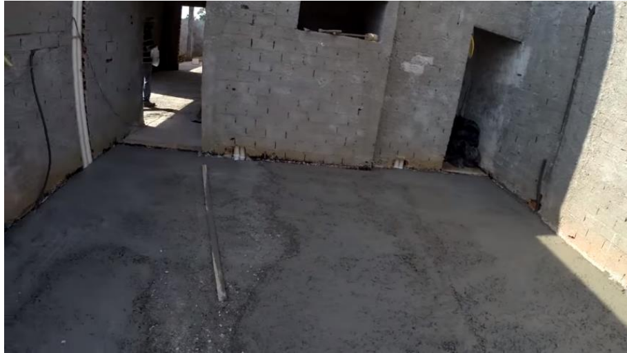
Figura 49 – Concretagem do contrapiso
