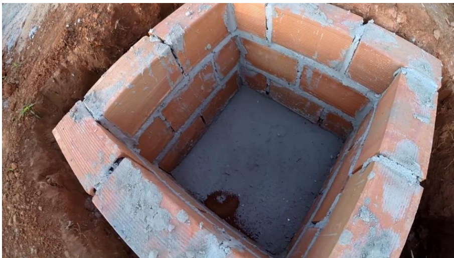
Figura 26 – Caixa de entrada de esgoto
