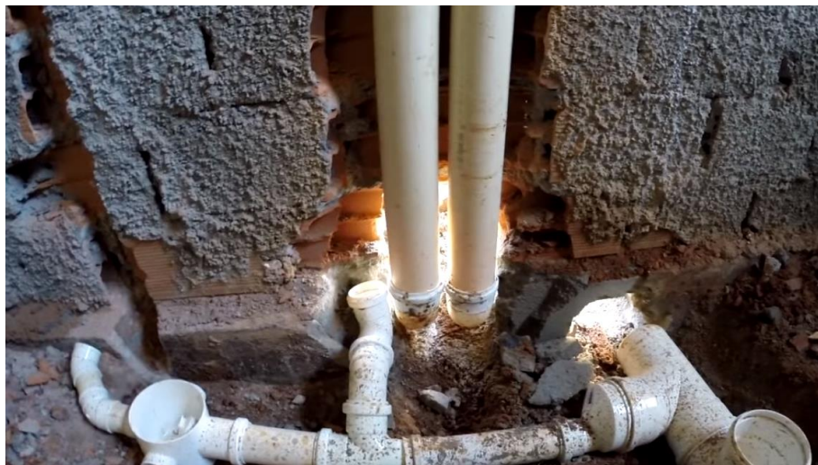
Figura 46 – Passagem das tubulações hidrossanitárias
