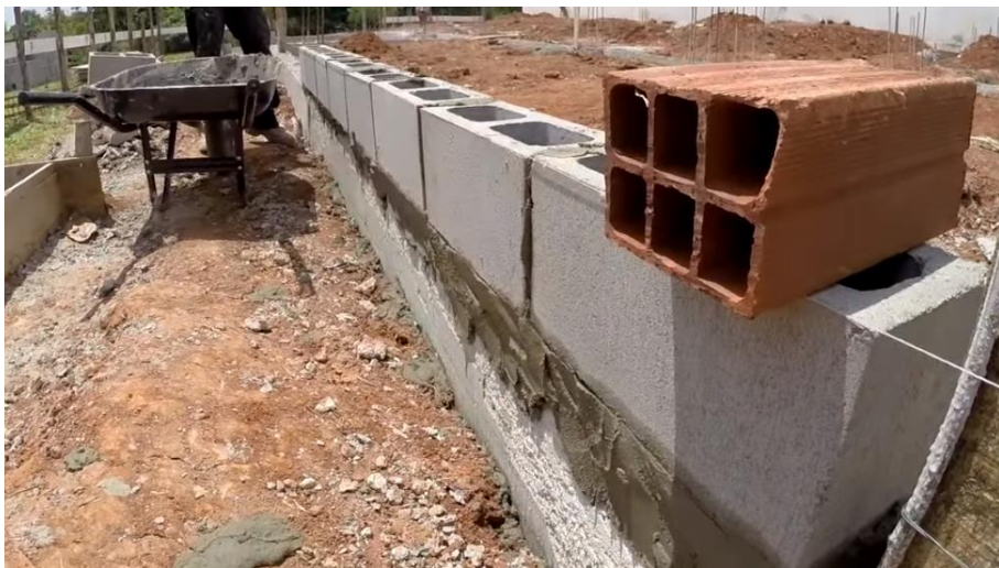
Figura 22 – Assentamento dos blocos da alvenaria de embasamento
