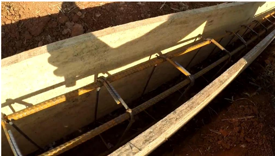
Figura 20 – Formas e armação das vigas baldrame
