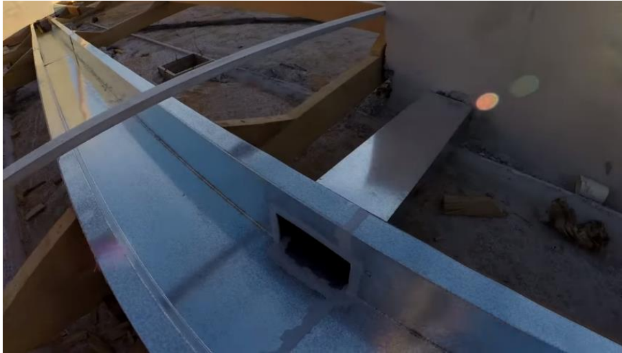
Figura 53 – Instalação das calhas
