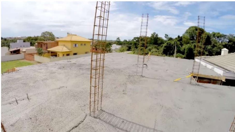
Figura 40 – Concretagem da laje
