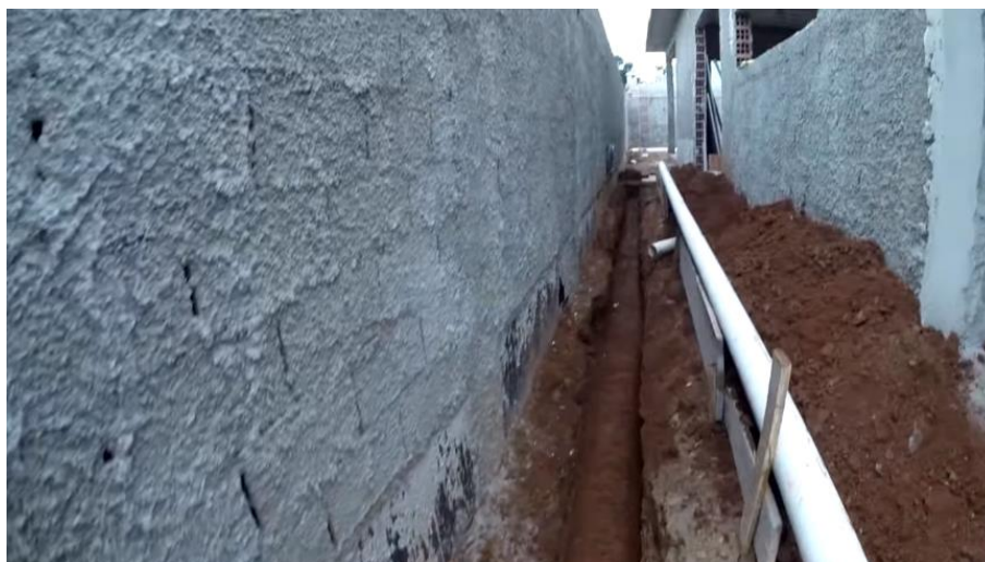
Figura 65 – Instalação das tubulações de esgoto
