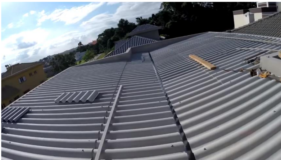
Figura 54 – Instalação das telhas de fibrocimento
