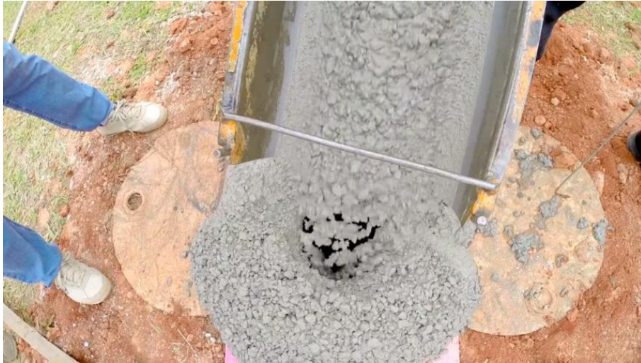
Figura 15 – Concretagem das estacas
