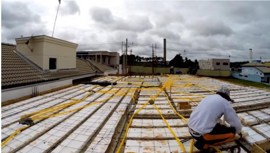
Figura 37 – Posicionamento das vigotas e ferragens da laje
