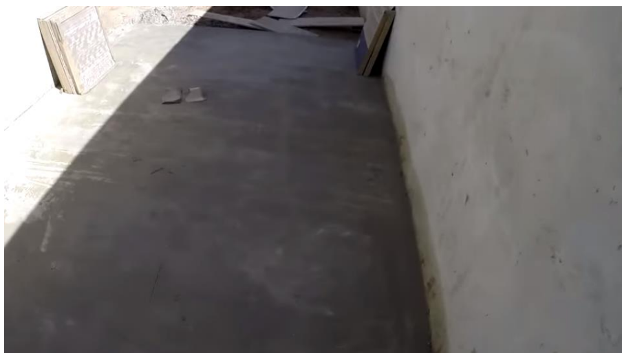
Figura 72 – Concretagem da calçada
