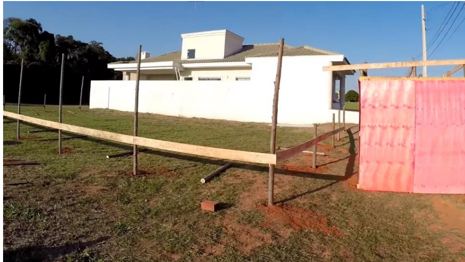
Figura 13 – Montagem do canteiro de obras
