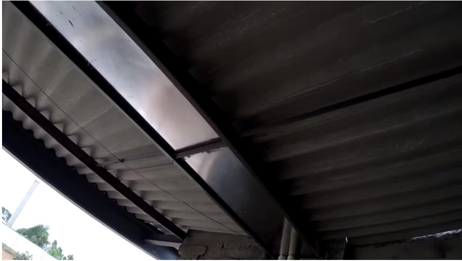
Figura 59 – Instalação as telhas da garagem
