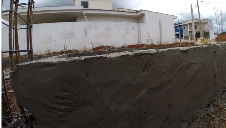
Figura 23 – Reboco e regularização da superfície das vigas baldrames
