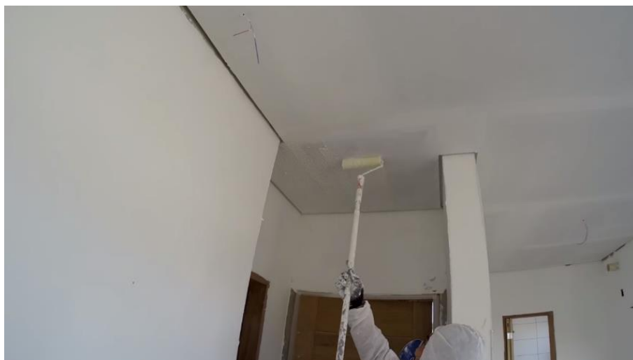
Figura 71 – Aplicação da massa corrida
