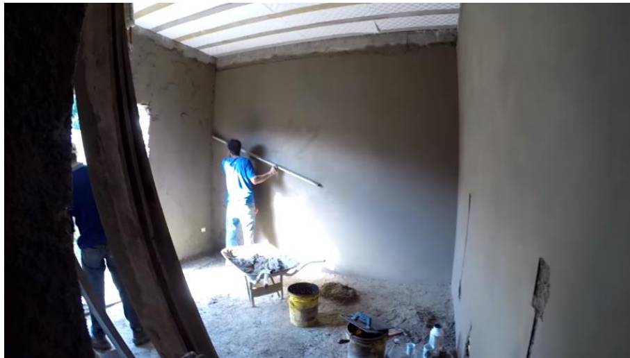
Figura 55 – Reboco da parte interna
