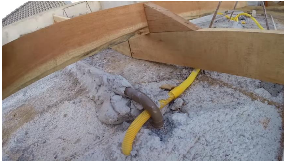
Figura 51 – Instalação das tubulações hidráulicas
