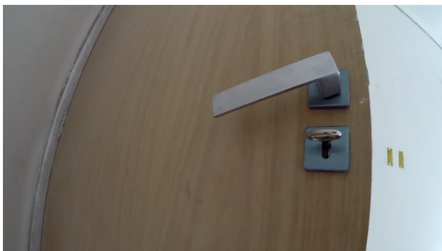
Figura 70 – Instalação das portas de madeira
