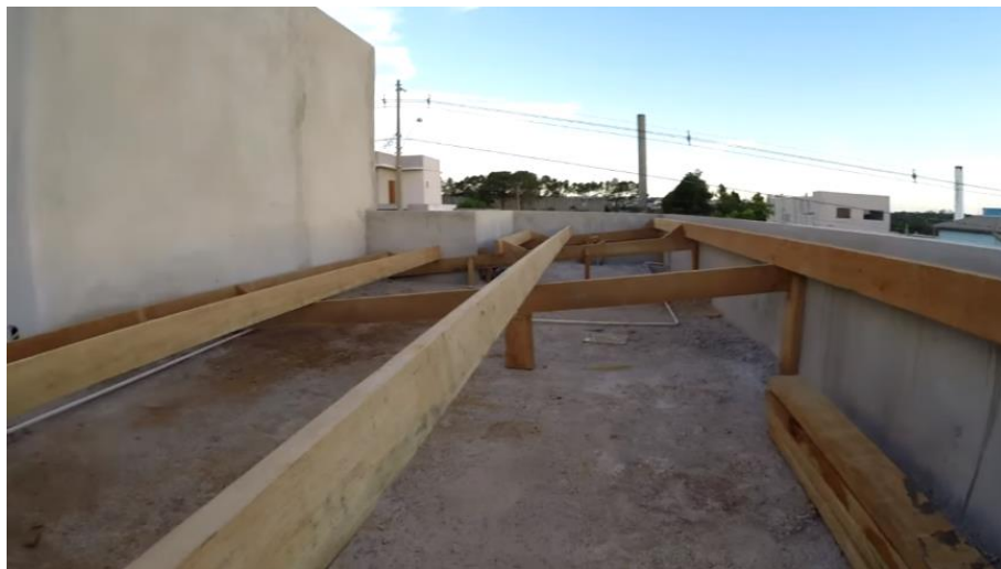
Figura 52 – Estrutura do telhado
