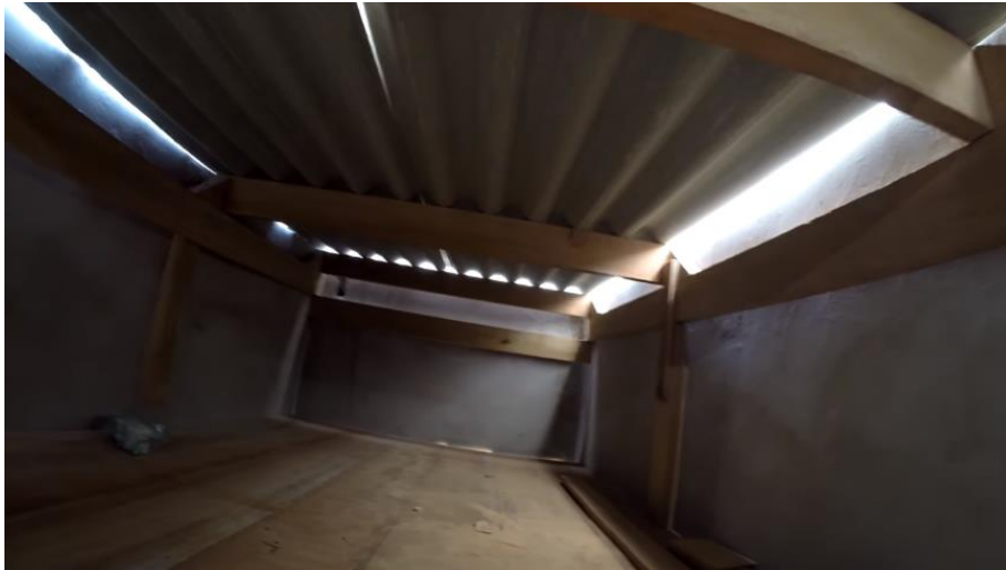
Figura 56 – Estrutura da caixa d'água
