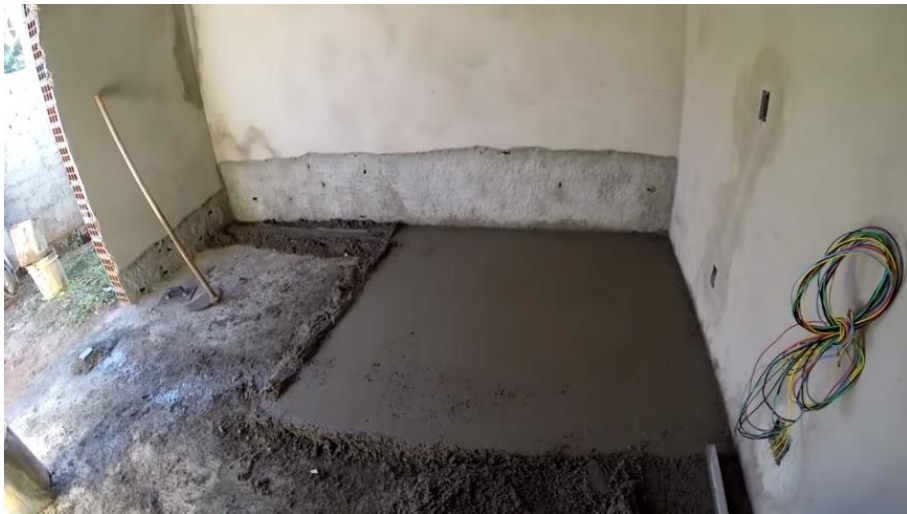
Figura 60 – Regularização do piso
