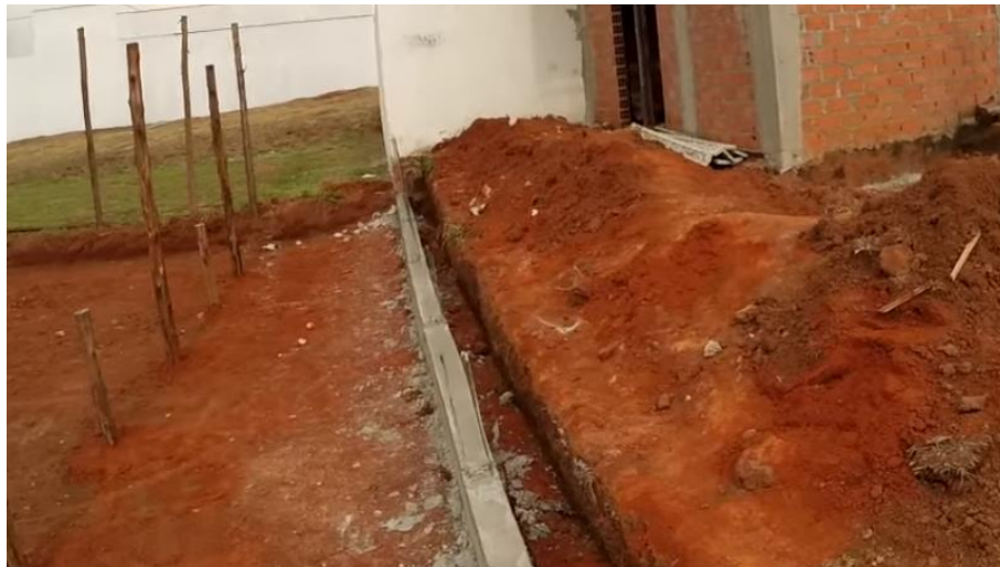
Figura 41 – Concretagem das vigas baldrame do muro de divisa
