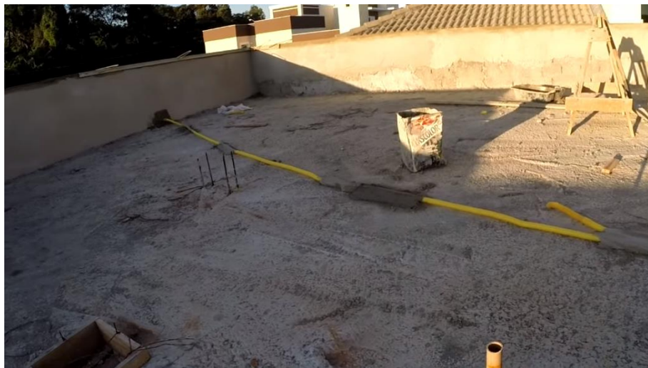
Figura 50 – Passagem das tubulações elétricas
