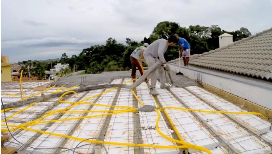
Figura 39 – Concretagem da laje
