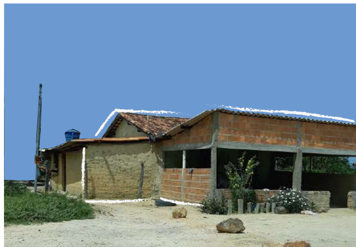
Tipologia Mista - Adobe e Alvenaria
