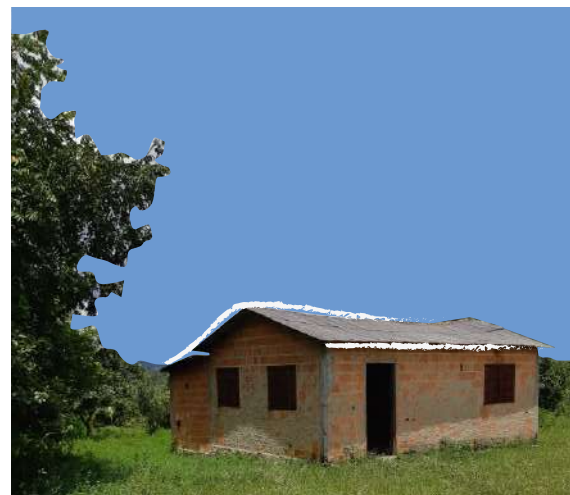
Novas construções Alvenaria
