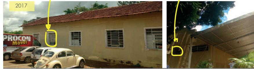
As esquadrias em ferro das fachadas norte e leste permaneceram com sua materialidade inalterada, e as adições feitas também apresentam mesmo material. A cobertura da edificação se mantém em telha francesa e a cobertura metálica da estação de embarque e desembarque que substituiu o telhado de duas águas na ampliação de 70 passa periodicamente por reformas.
