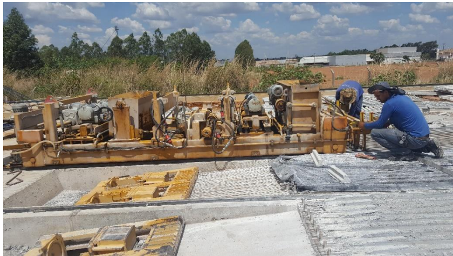
Figura 2 – Pista de protensão na fabricação do concreto protendido
