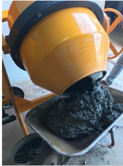
Figura 14 - Produção do concreto na betoneira
