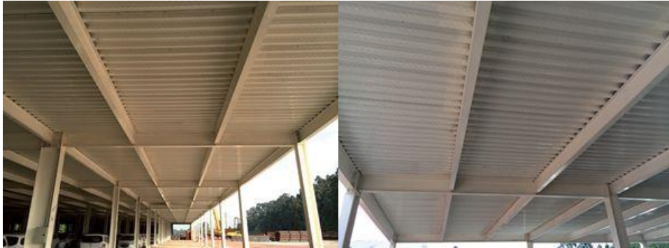
Figura 3 - Face inferior das formas pintadas, para garantir maior durabilidade
