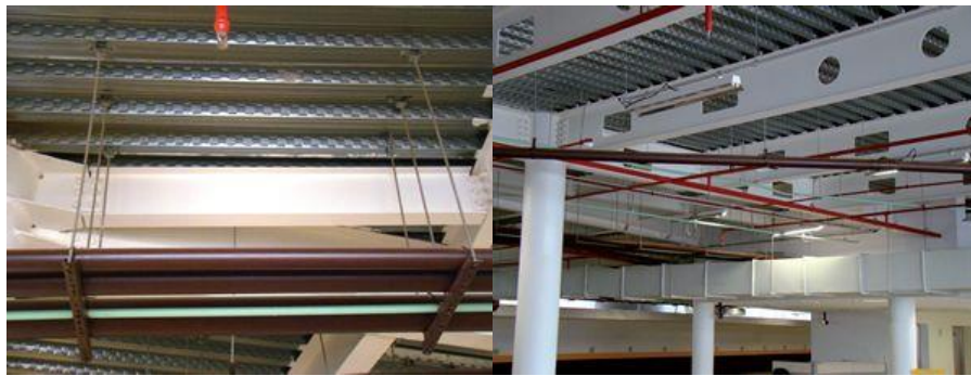
Figura 4 - Instalações aparentes
