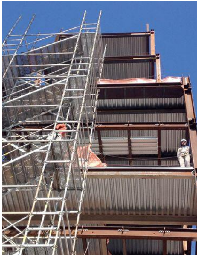
Figura 1 - Aplicação de steel deck em edifício de múltiplos andares
