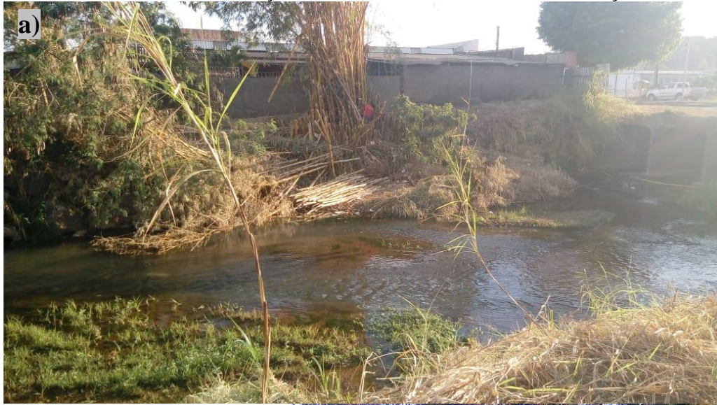
Figura 41 - Imagens do ponto de observação – Área 3. a) Vegetação predominante. b) Ausência de trabalhos de contenção. c) Proximidade do leito com as construções.
