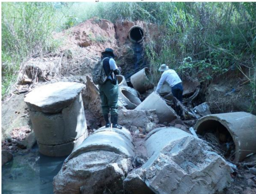
Figura 16 - Afluente do Anta recebendo a deposição de resíduos industriais e comerciais de estabelecimentos instalados ao longo da Avenida Brasil Norte
