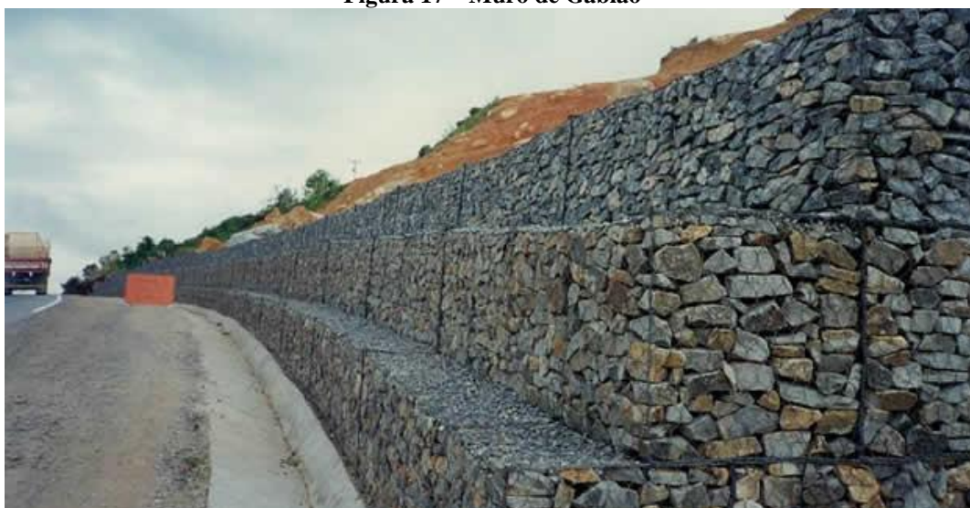
Figura 17 – Muro de Gabião
