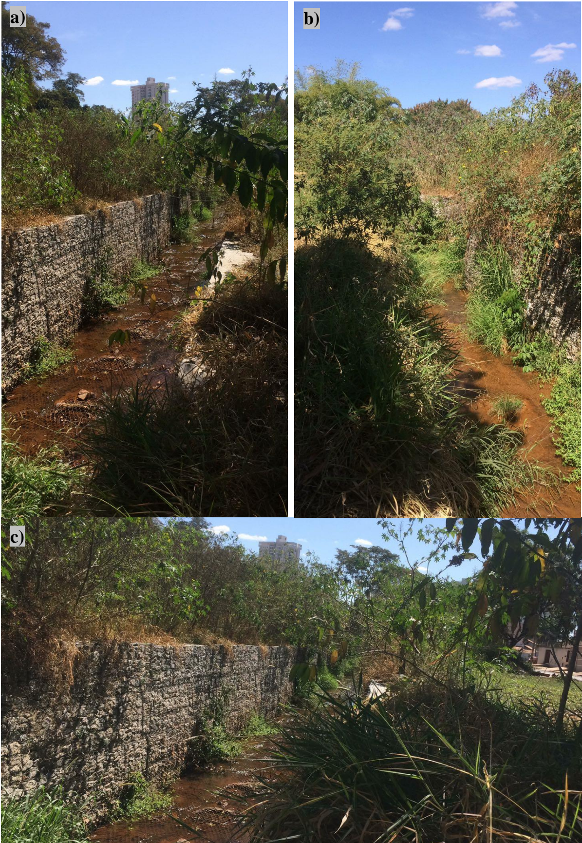
Figura 21 - Imagens do primeiro ponto de observação. a) Trabalhos de contenção do solo. b) Canal assoreado. c) Vegetação predominante.
