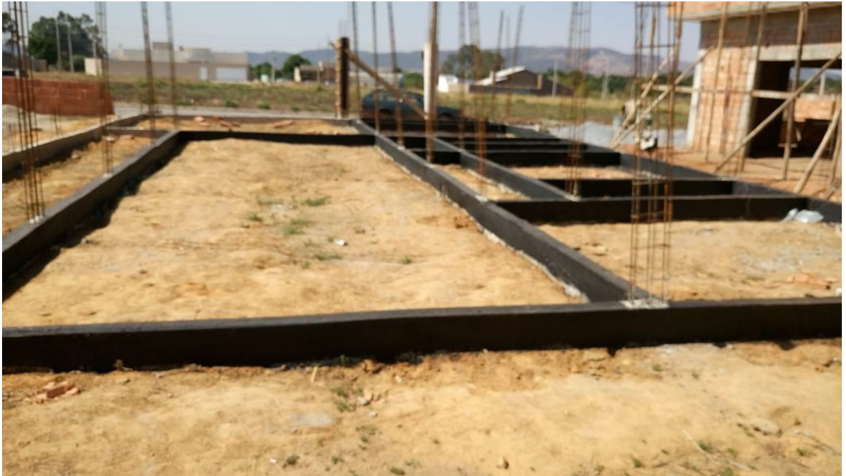
Figura 3 – Impermeabilização das vigas baldrame.
