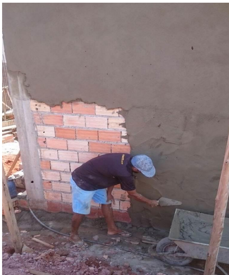
Figura 22 – Aplicação da argamassa com impermeabilizante para revestimento da alvenaria.
