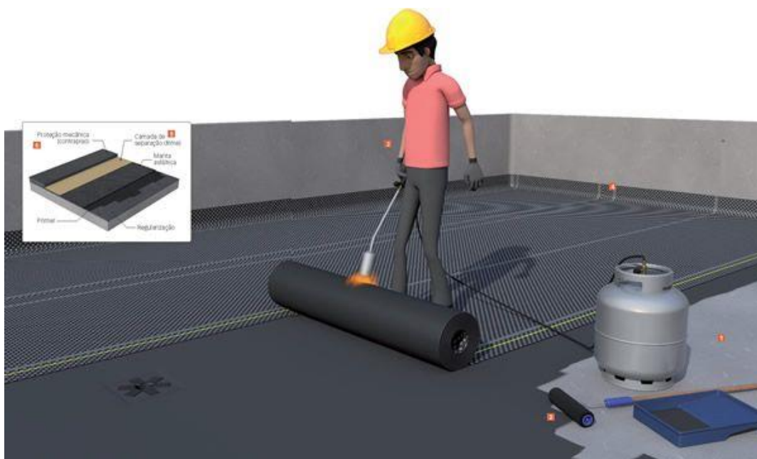
Figura 2 - Aplicação da Manta Asfáltica.
