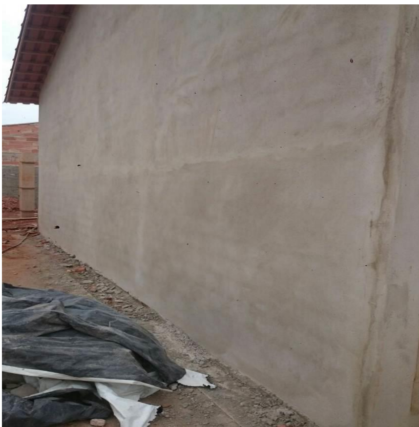
Figura 23 – Parede após 10 dias após reboco.
