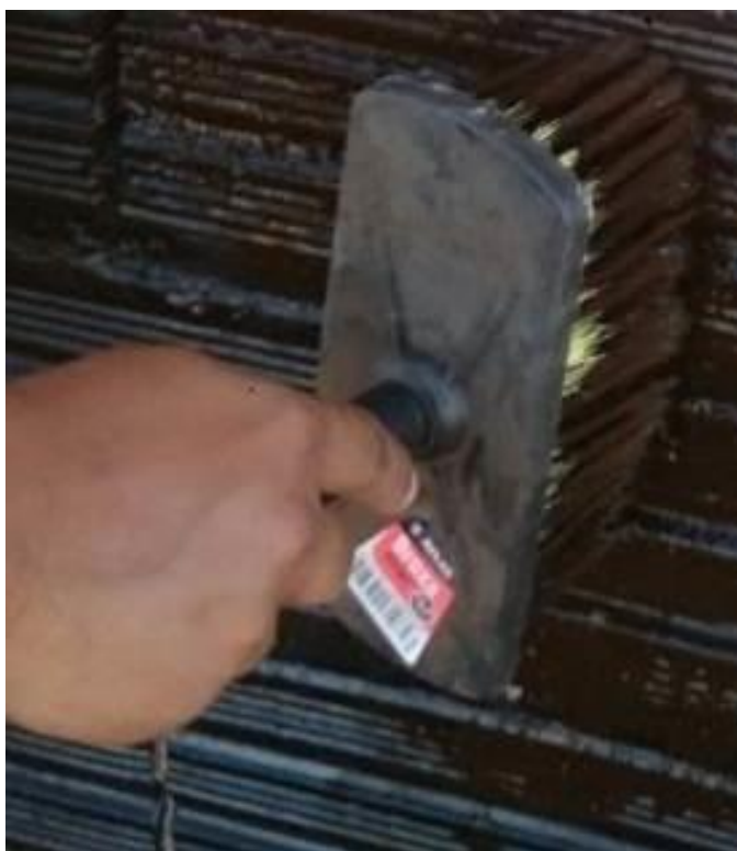
Figura 8 – Broxa na aplicação da emulsão asfáltica.
