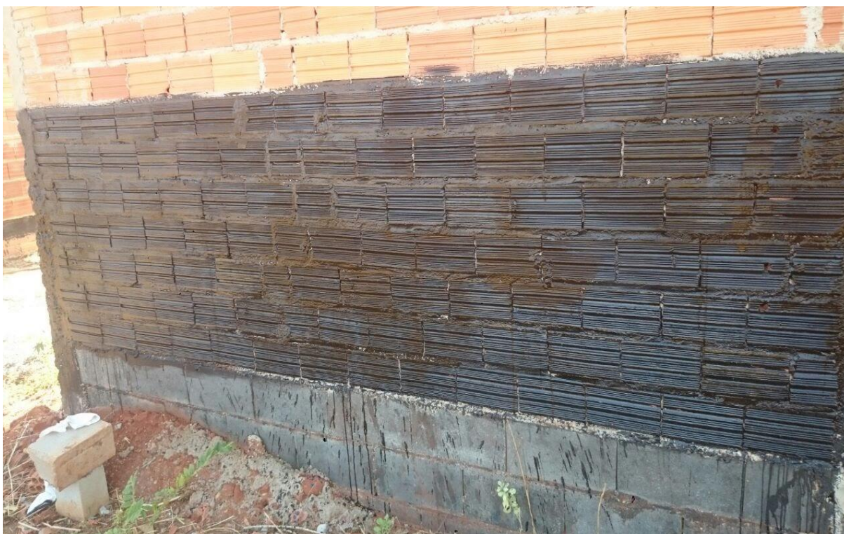
Figura 14 – Parede do imóvel em detalhe, após a aplicação do impermeabilizante flexível.
