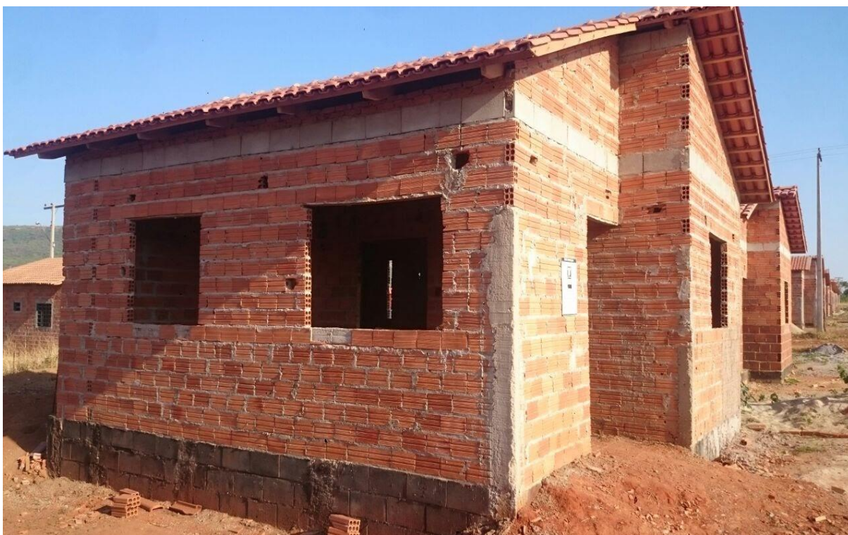
Figura 9 – Obra para aplicação do impermeabilizante de emulsão asfáltica.
