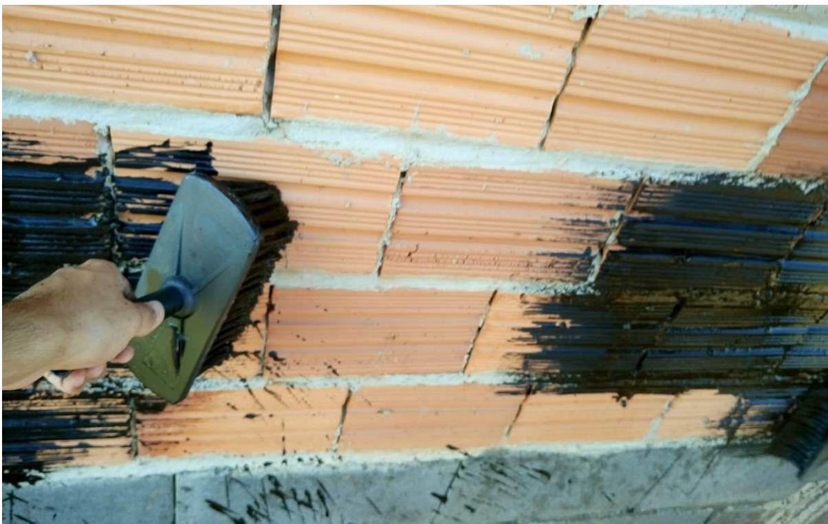
Figura 10 – Aplicação da primeira demão do impermeabilizante, no sentido horizontal.
