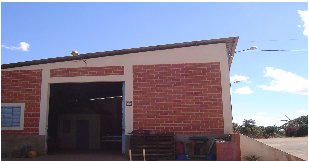
Figura 29: Armazém de acondicionamento de embalagens: oitava propriedade rural
