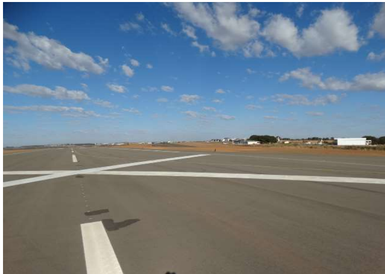
Figura 35 - Pista de pouso e decolagem asfaltada e sinalizada.
