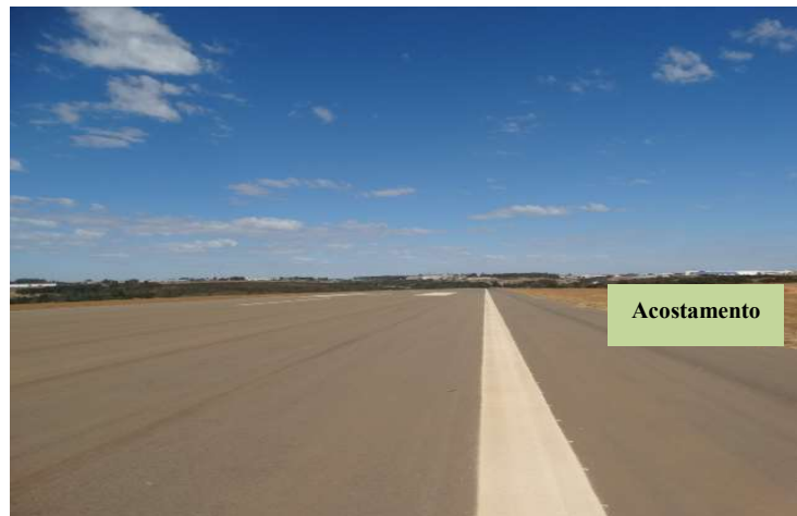
Figura 37 - Acostamento da pista de pouso e decolagem
