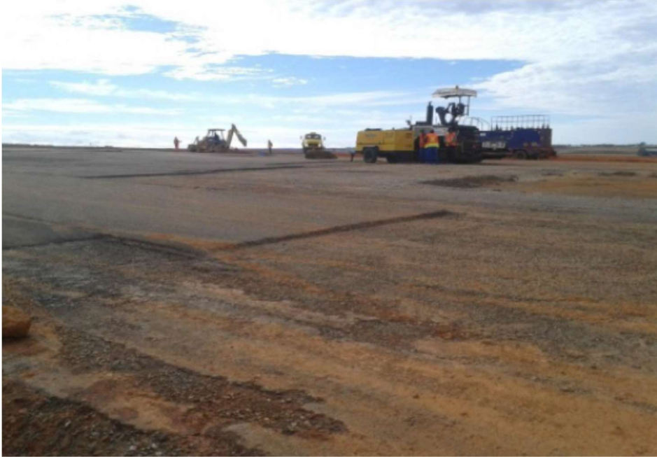
Figura 33 - Revestimento flexível betuminoso por mistura do Aeroporto de Cargas de Anápolis
