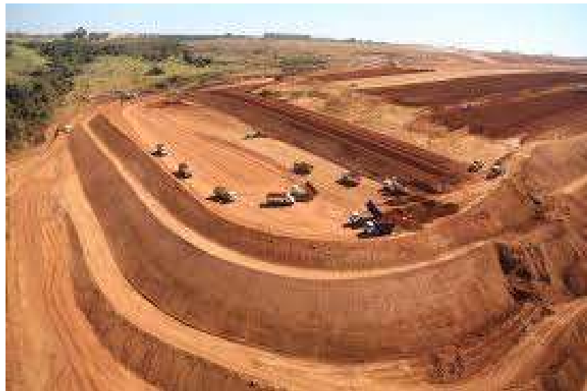
Figura 28 - Aterramento do corpo principal da cabeceira 6
