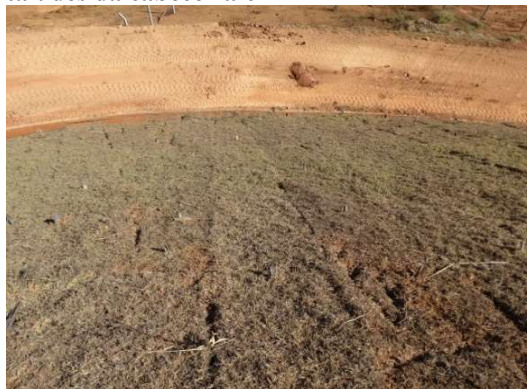
Figura 44 - Placas de grama utilizadas nos taludes da cabeceira 6
