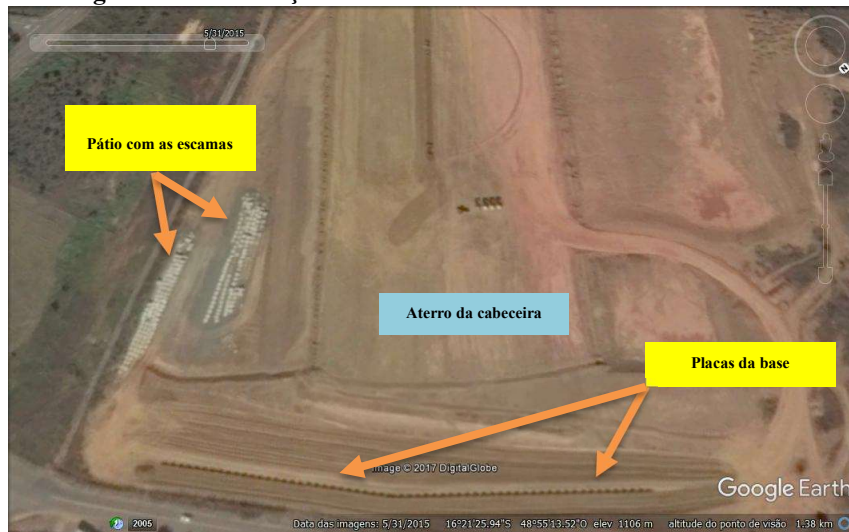
Figura 25 -Construção do muro simultaneamente com o aterro.
