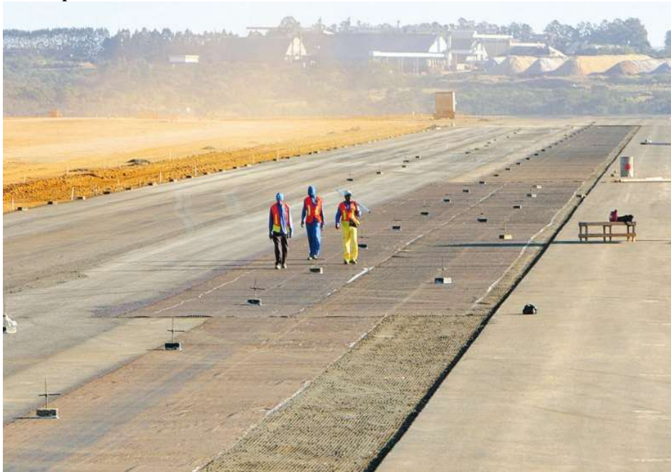
Figura 34 - Revestimento flexível betuminoso por mistura do Aeroporto de Cargas de Anápolis
