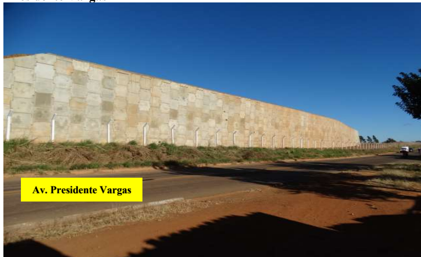
Figura 24 -Vista frontal do muro de arrimo terra armada para a Av Presidente Vargas
