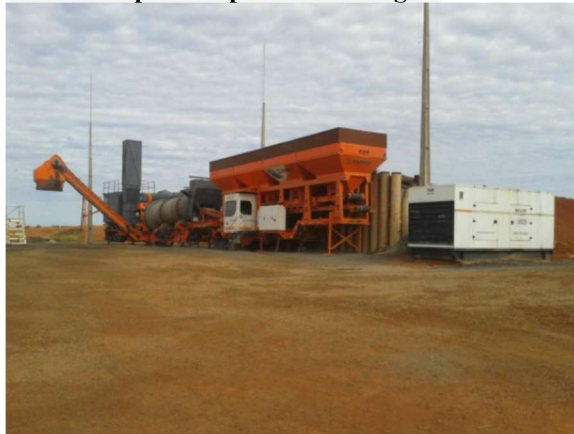
Figura 30 - Fábrica de manta asfáltica montada ao lado da pista de pouso e decolagem
