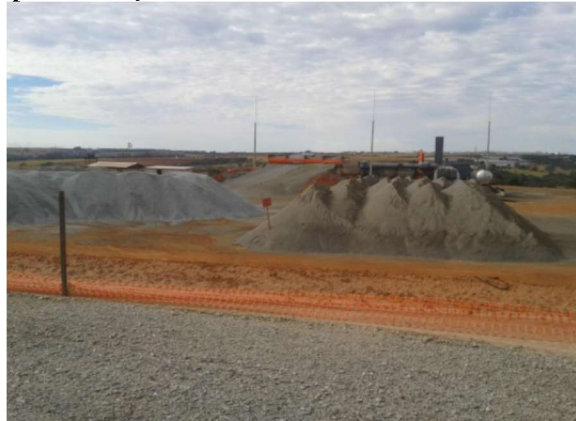
Figura 31 - Pilhas de agregados usados na pavimentação
