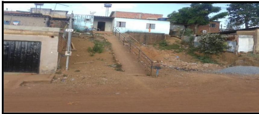
Figura 16 - Registro fotográfico que revelam a precariedade urbana de algumas moradias encontradas no AP localizado no Jardim São Paulo, 2016.
