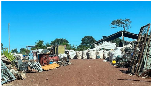
Figura 6 – Galpão da cooperativa de triagem de materiais recicláveis. Fonte: autora.
