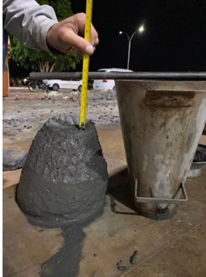
Figura 5 - Realização do slump test
