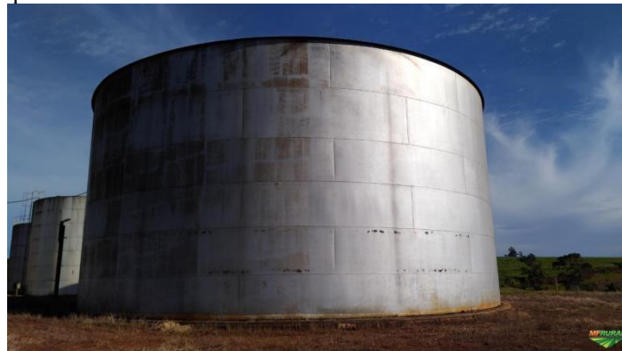
Figura 1 – Tanques de Armazenamento Combustível em São José do Rio Preto - SP.
