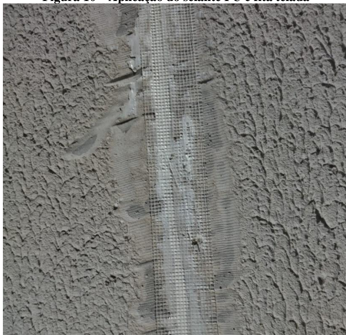
Figura 10 – Aplicação do selante PU e fita telada
