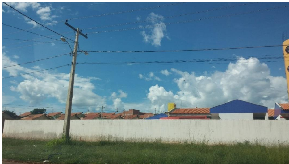
Figura 27- Área pública municipal: 5.770,90m 2 . Creche em obras.
