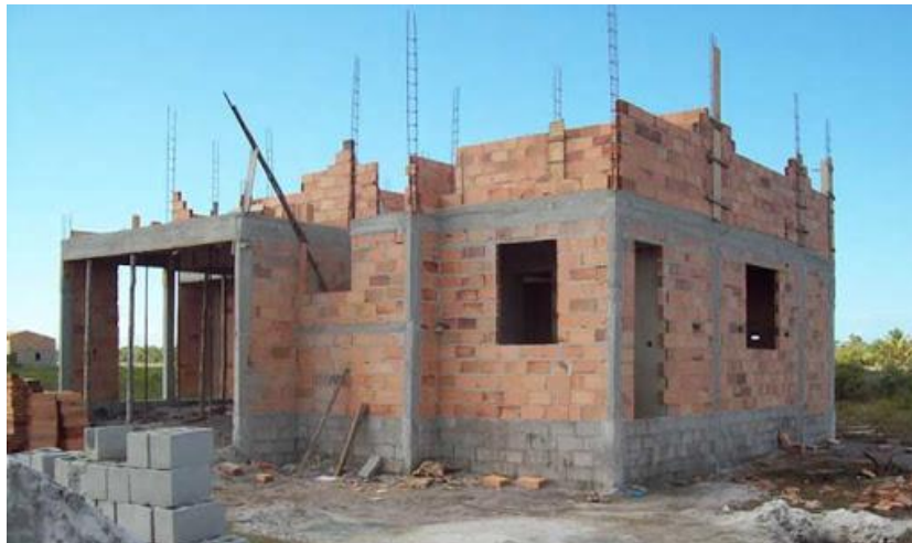
Figura 15 – Alvenaria de vedação
