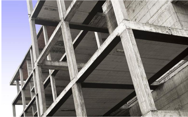
Figura 12 – Elementos de concreto armado
