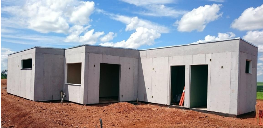
Figura 10 – Revestimento externo com placa cimentícia
