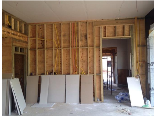
Figura 9 – Instalação elétrica
