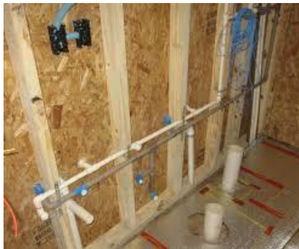
Figura 8 – Instalação hidráulicas
