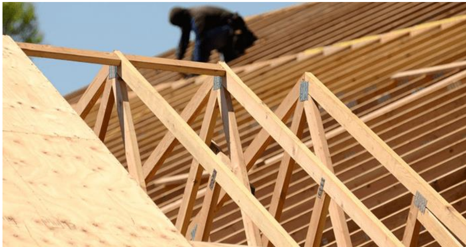
Figura 11 – Estrutura do telhado
