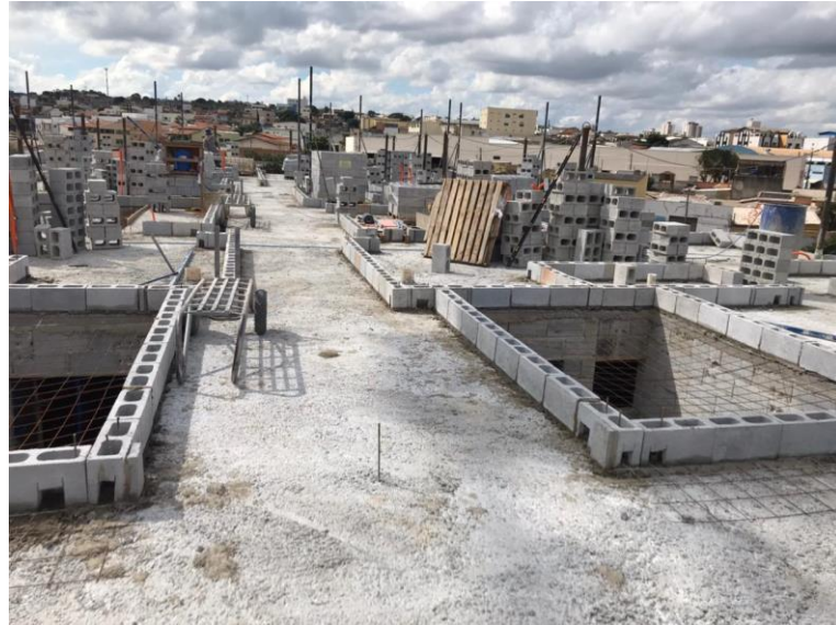
Figura 28 - Marcação da primeira fiada da alvenaria estrutural
