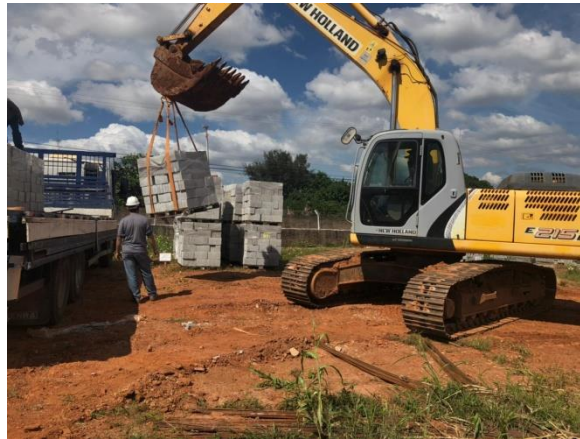
Figura 16 - Descarga de blocos de concreto
