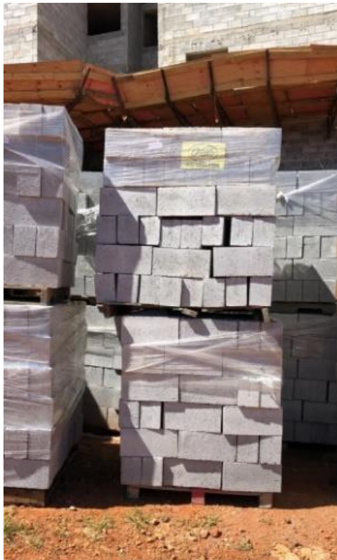
Figura 25 - Paletes de blocos de concreto, armazenamento do material
