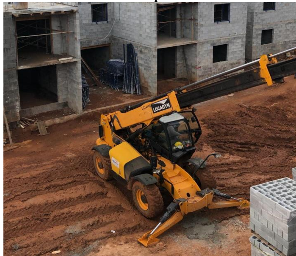
Figura 19 - Abastecimento utilizando o manipulador telescópico
