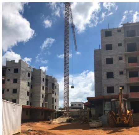
Figura 20 - Local da grua no canteiro
