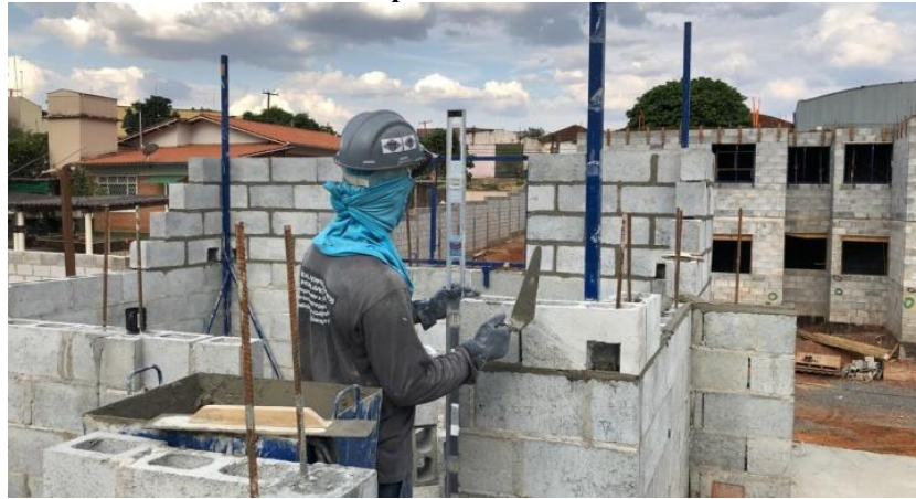
Figura 11 - Elevação da alvenaria estrutural armada e uso da régua prumo nível
