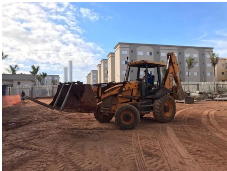
Figura 23 - Retroescavadeira com garfo na pá carregadeira
