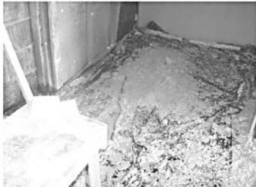
(a) Proteção do piso
