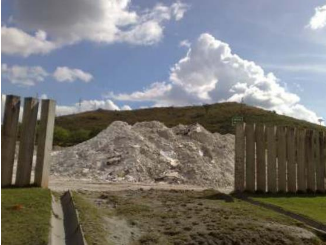
Figura 32 - Estoque de resíduos de gesso em indústria cimenteira
