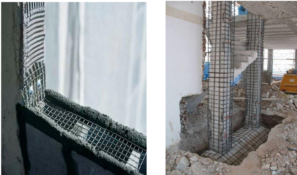
Figura 4 - Utilização de telas em estruturas de alvenaria.
