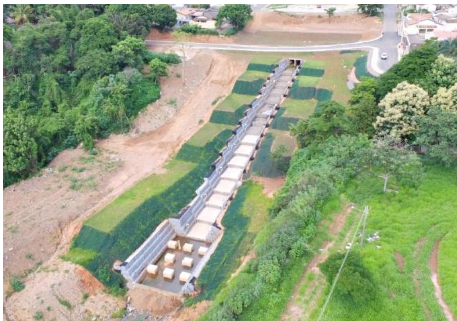
Figura 14 – Local da erosão após a obra.
