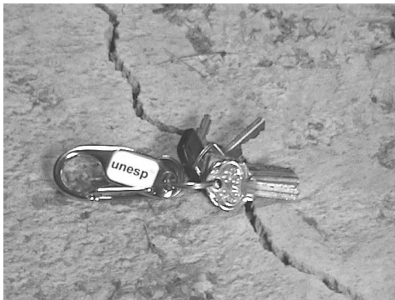
Figura 06 – Trinca na laje por colapso no solo
