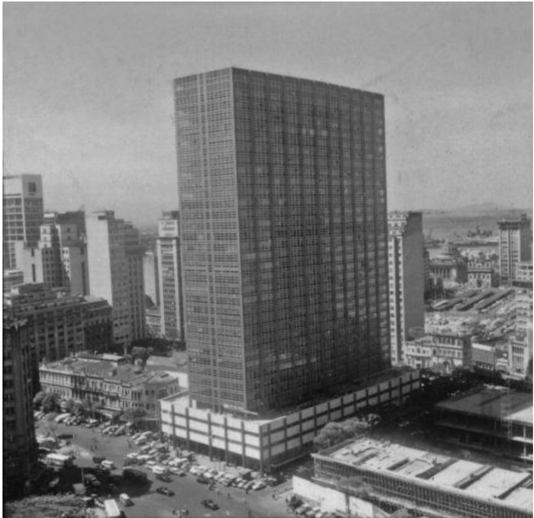
Figura 1 – Edifício avenida central
