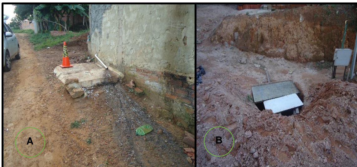
Figura 5: Fossa 5A; Construção de fossa 5B
