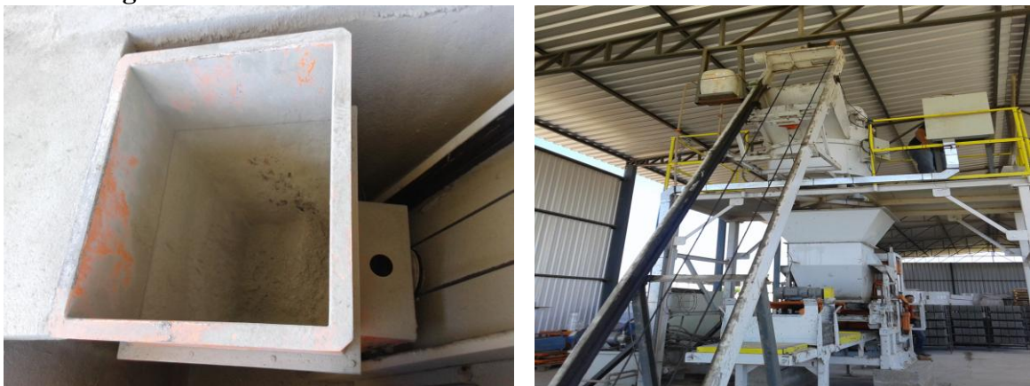
Figura 8 – Detalhe do acondicionamento dos materiais levados na esteira
