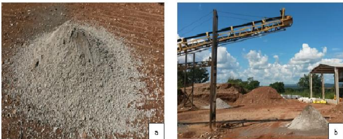
Figura 6 – Material acondicionado separadamente no pátio da empresa RNV.
