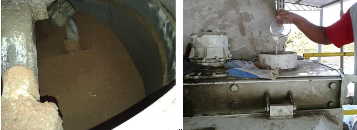
Figura 9 – Detalhe da adição de água e aditivo
