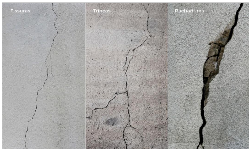
Figura 4 - Tipos de abertura na alvenaria
