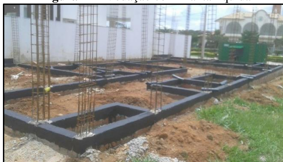
Figura 12 - Vedação com manta líquida
