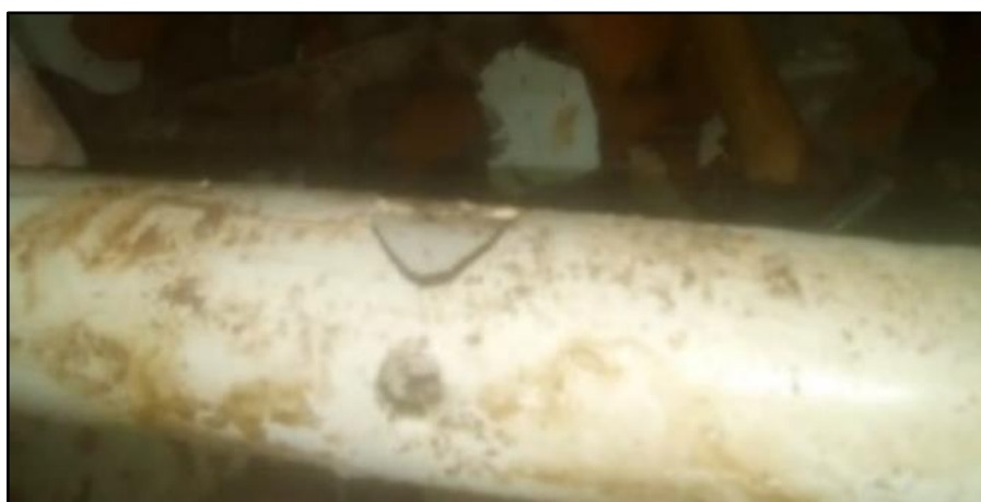
Figura 14 - Abertura do conduto hidráulico
