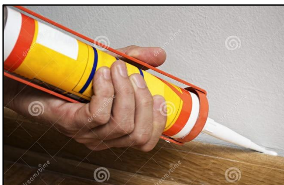
Figura 13 - Processo de calafetagem
