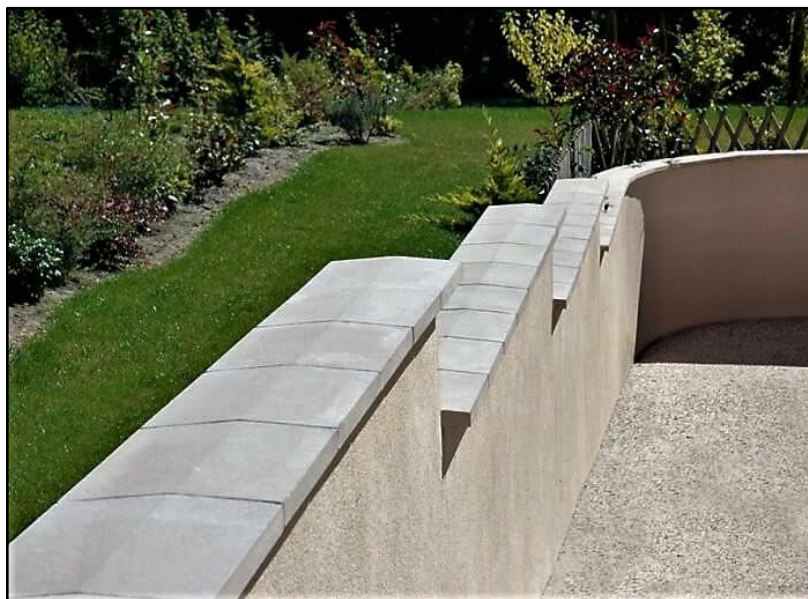
Figura 22 - Pingadeira de concreto
