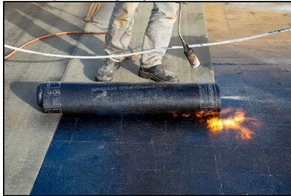
Figura 11 - Aplicação de manta asfáltica
