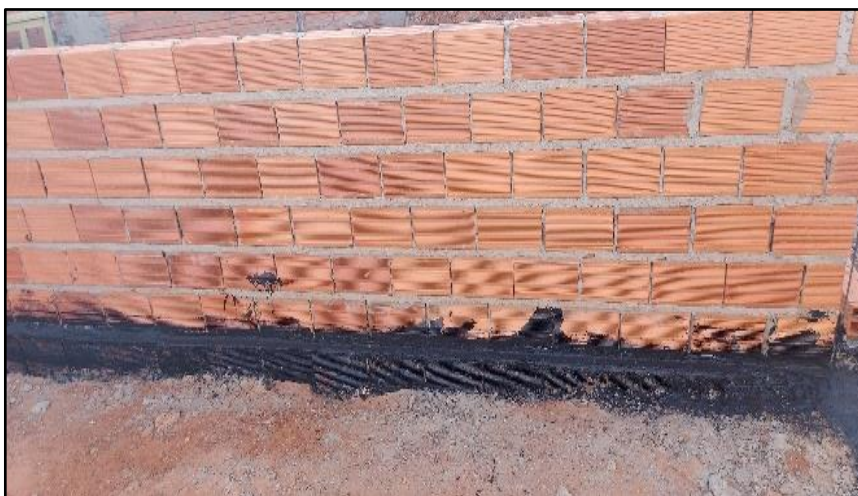
Figura 18 - Viga baldrame com cobertura de manta líquida
