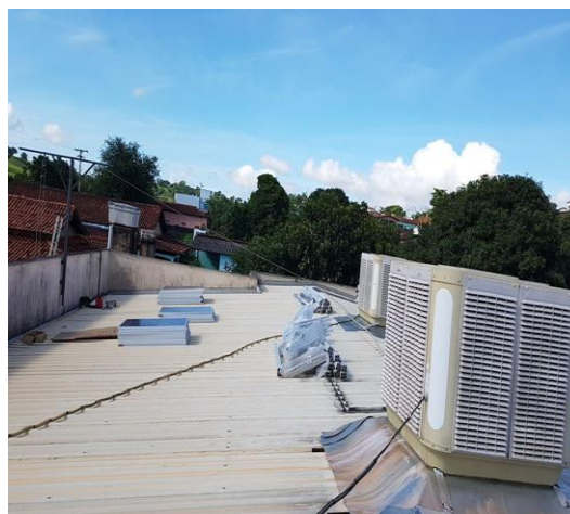
Início da instalação das placas fotovoltaicas.
