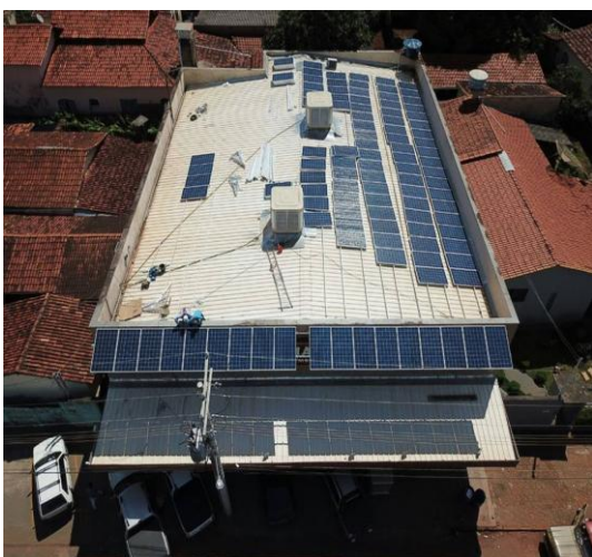
Instalação em andamento.
