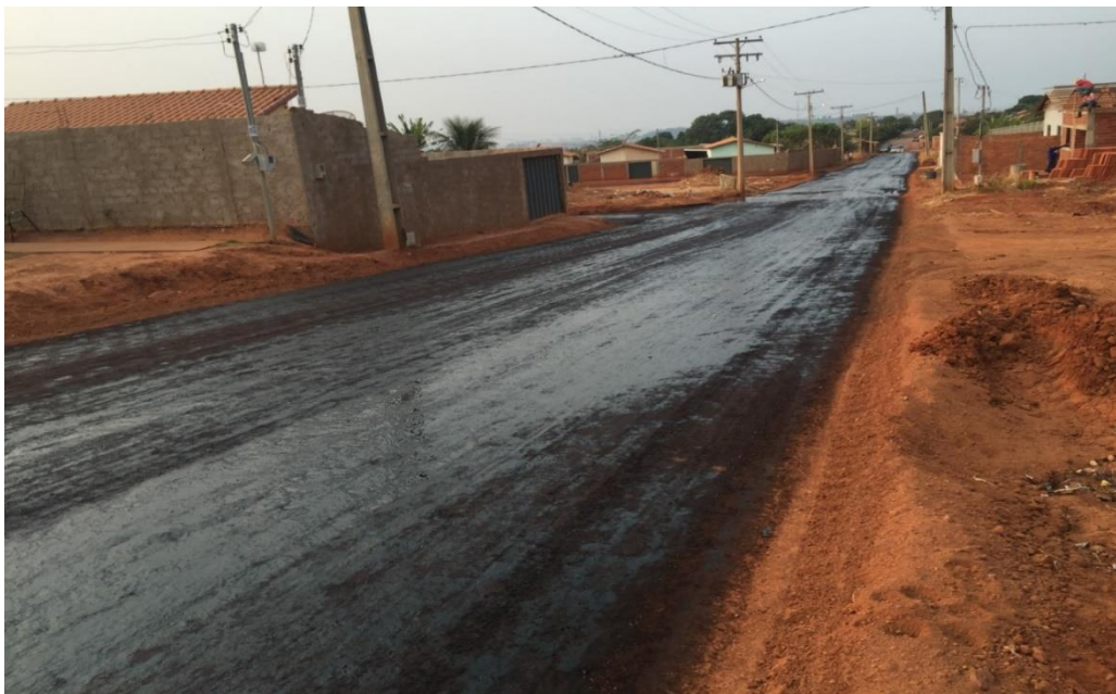
Figura 4 – Resultado da imprimação do RR-2C
