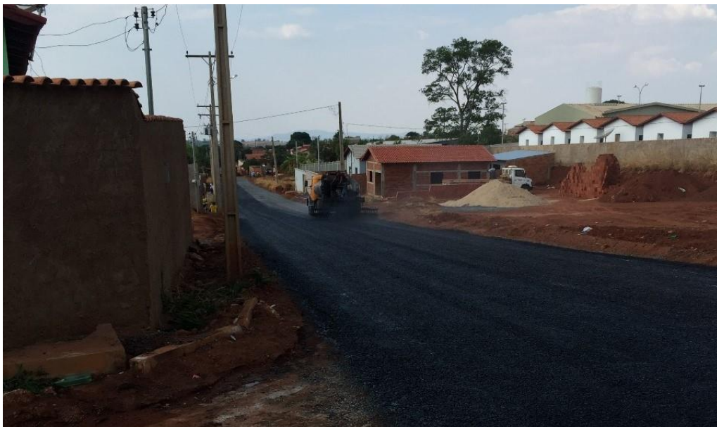
Imagem 7 – Caminhão espargidor imprimando a última camada de RR-2C
