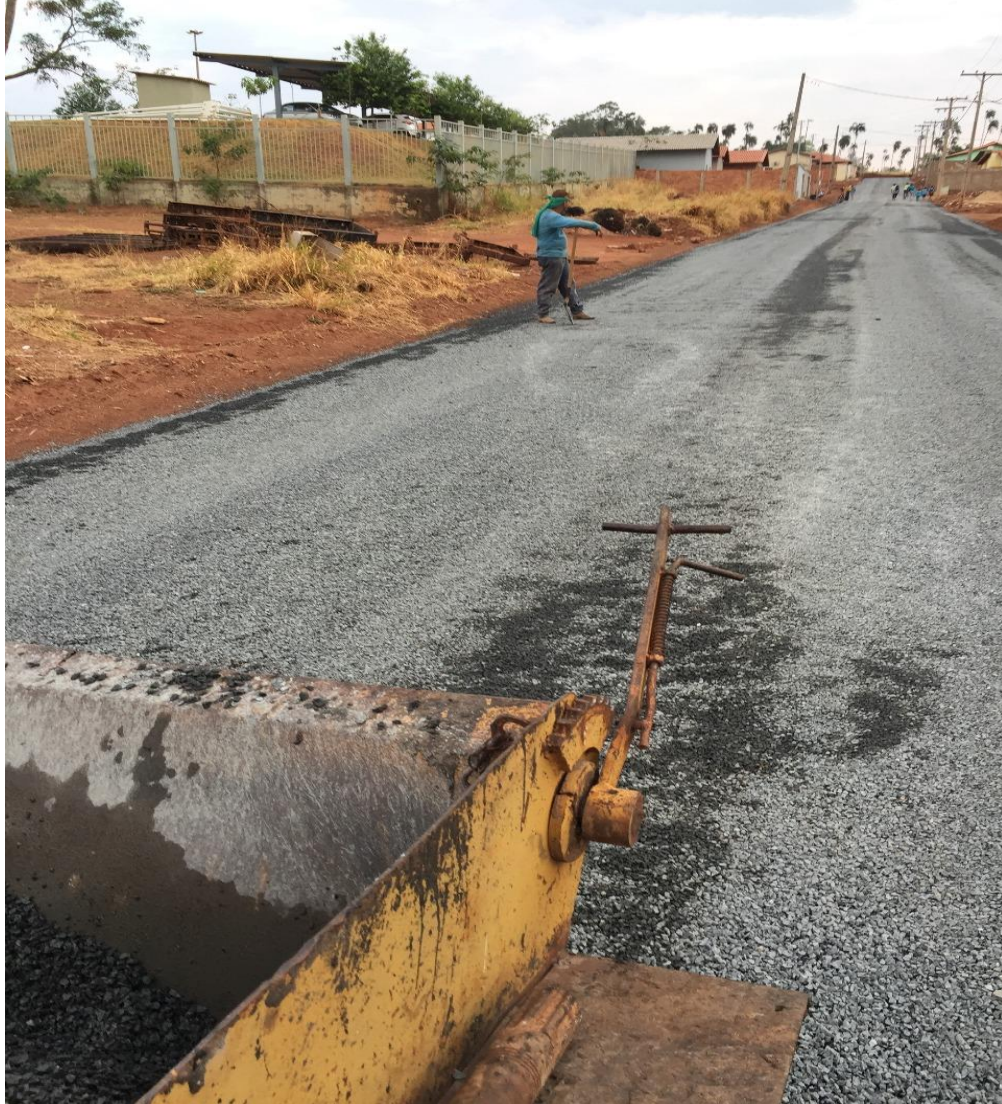
Figura 5 – Lançamento do agregado com Spread
