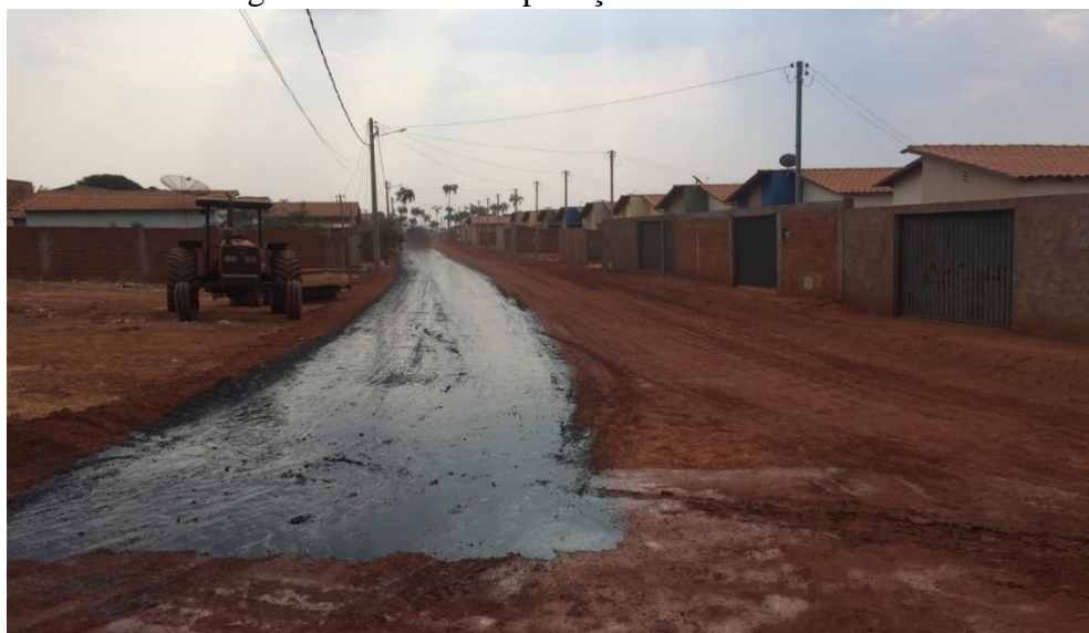
Figura 2 – Início da aplicação do CM-30 na via
