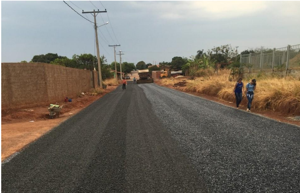
Figura 6 – Lançamento da segunda camada de agregados
