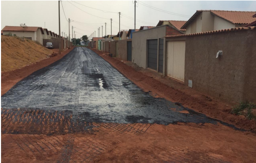
Figura 3 – Resultado da via após a aplicação do CM-30
