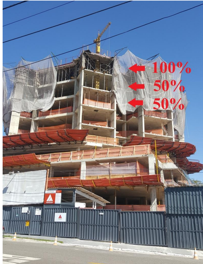
Figura 33 – Escoramento em 3 níveis
