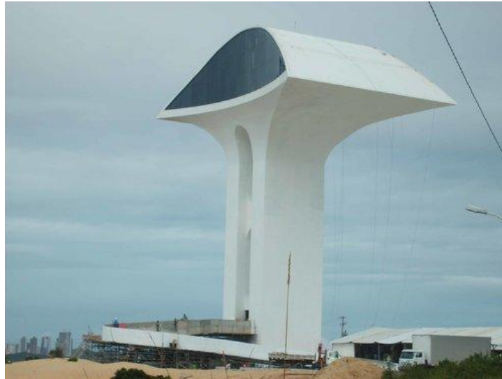
Figura 2 -Obra executada através de sistema de protensão aderente
