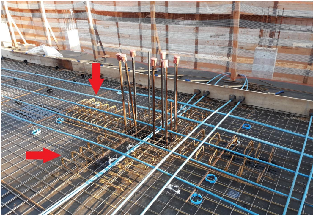
Figura 21 – Armadura de punção
