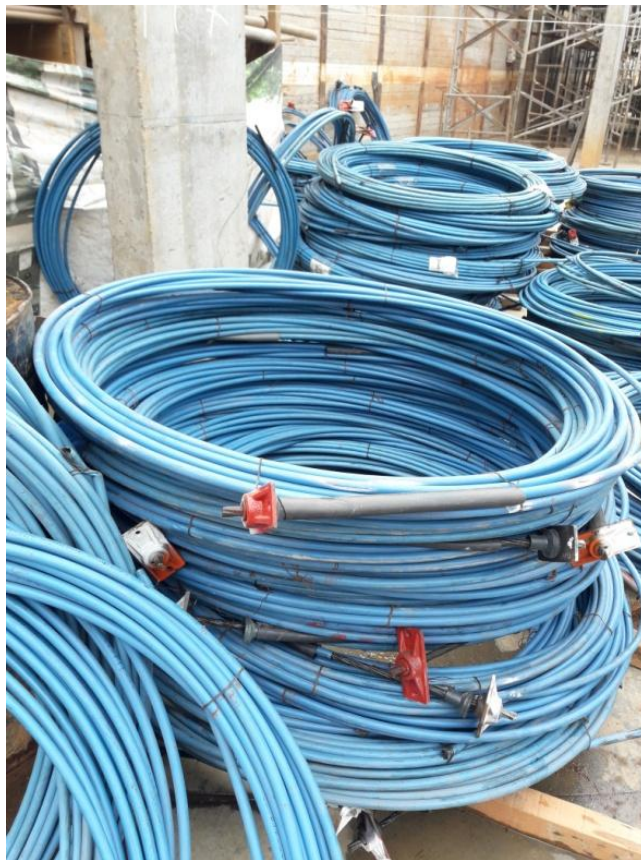
Figura 3 – Monocordoalhas engraxadas
