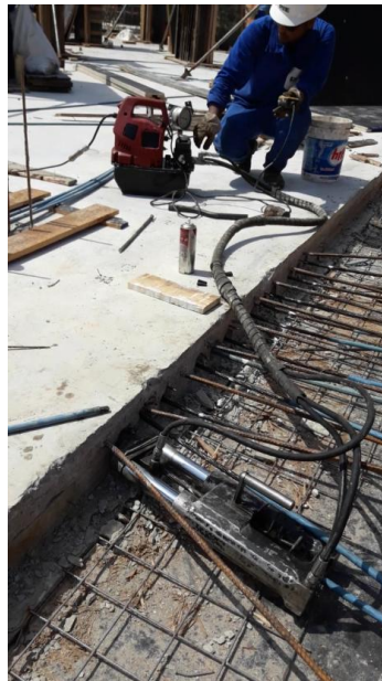
Figura 6 - Macaco hidráulico com pistões paralelos
