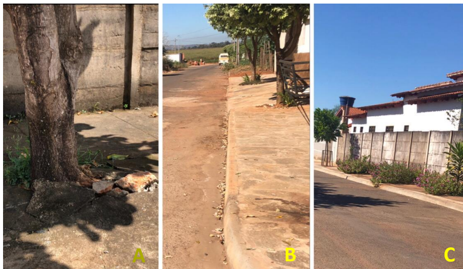
Figura 2 – Obstrução do passeio pela vegetação no Setor Jardim Presidente. Árvore na faixa de circulação (a) e (b). Vegetação rasteira obstruindo a passagem (c)
