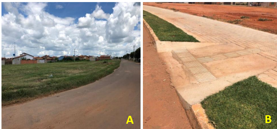
Figura 7 – Ausência de piso na calçada (a) e passeio público acessível (b)
